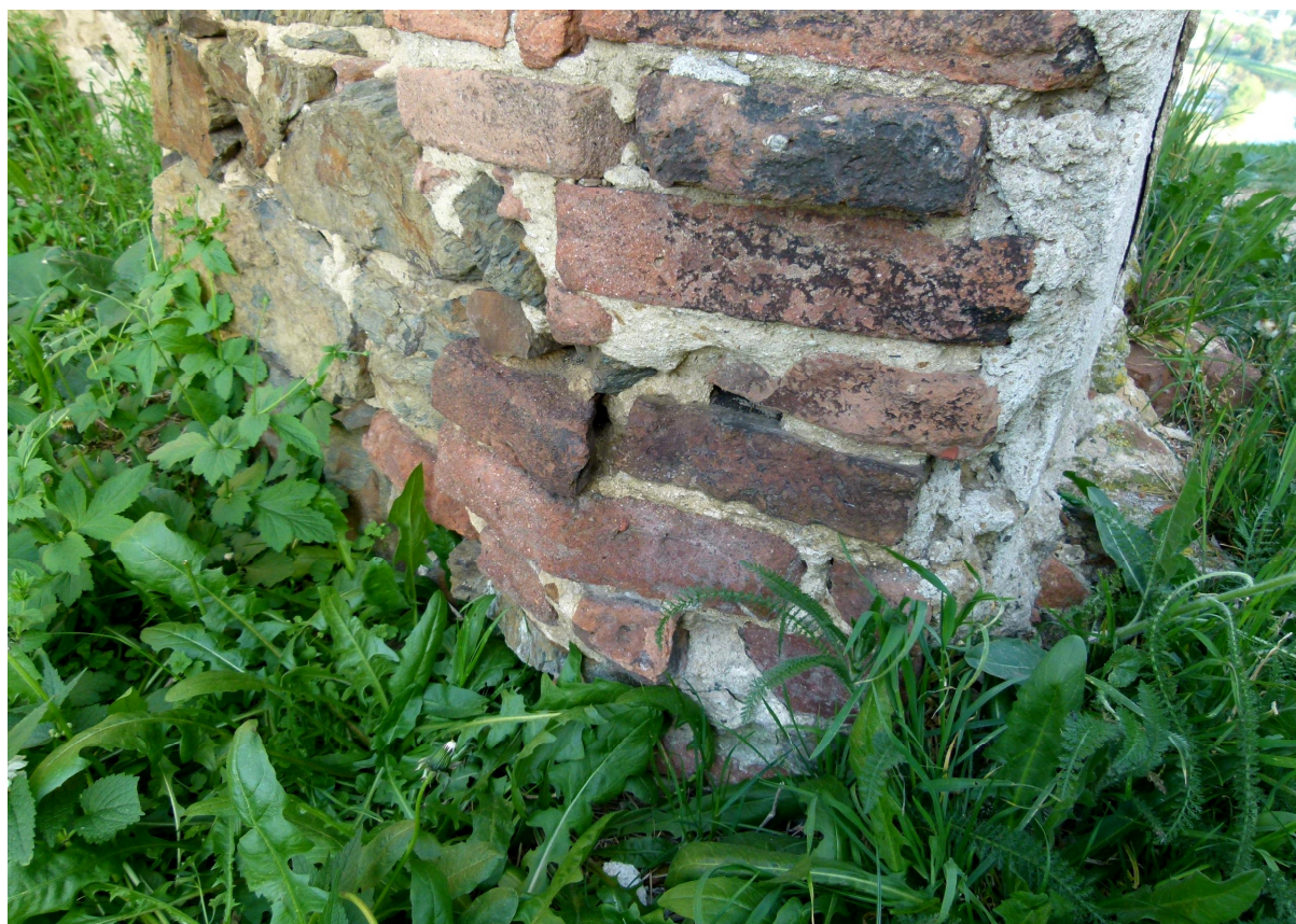
▲ Foto 20: Detail cihelné vyzdívky s okosením cihel.
