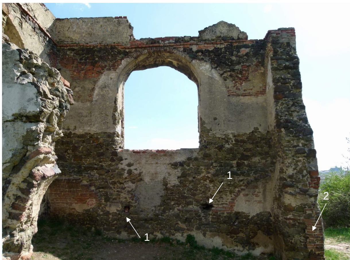
▲ Foto 17: Pohled na vnitřní stranu jihovýchodní zdi s velkým oknem v prvním patře (1 – kapsy po lešenářských trámech nebo ramenátu, 2 – nejspíše špaleta dveří).
