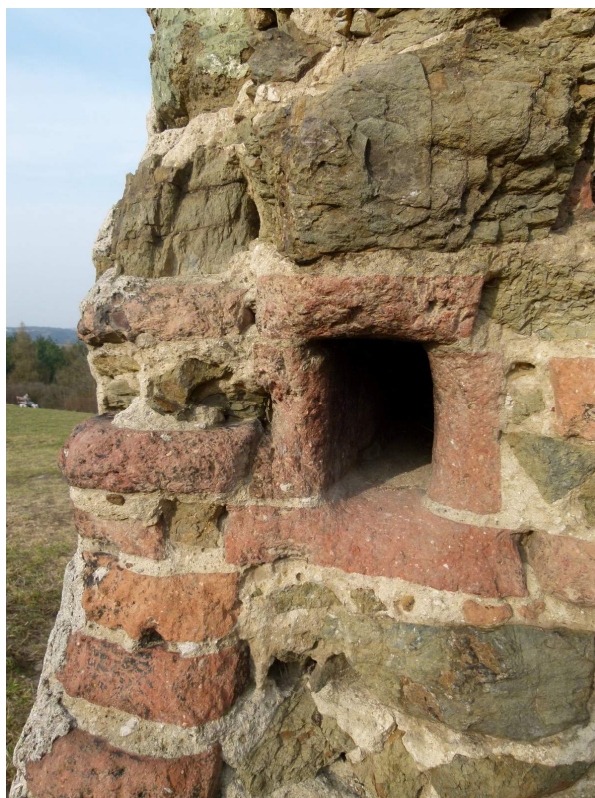
▲ Foto 12: Detail kapsy pro zasouvací závoru vstupních dveří
