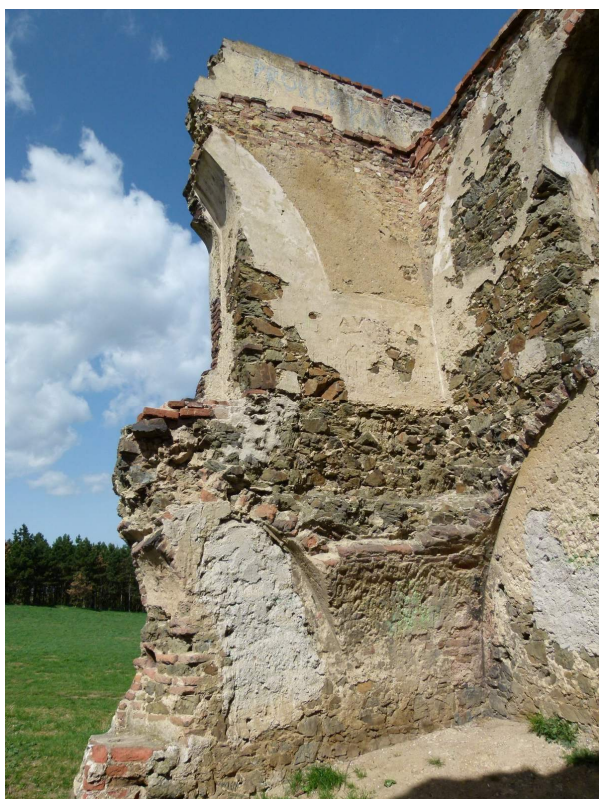
▲ Foto 13: Pohled na severozápadní zeď z interiéru.
