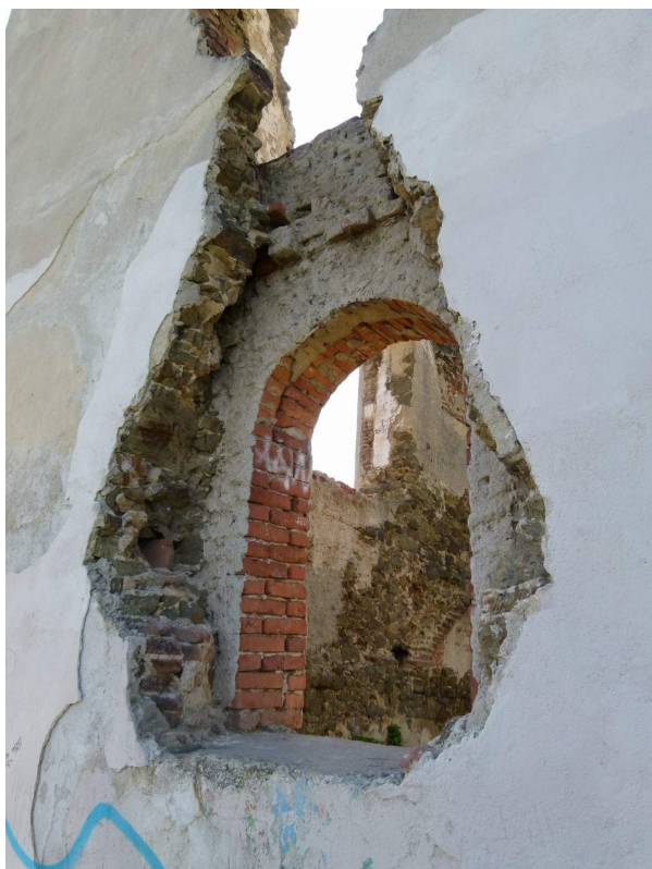
▲ Foto 07: Detail novodobé okenní špalety.
