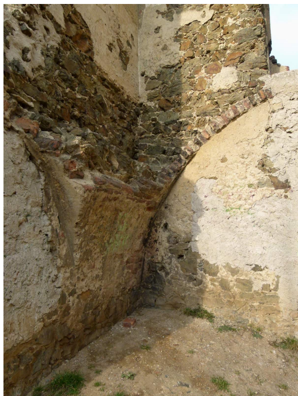
▲ Foto 15: Detail paty klenby v severním rohu. ▲ Foto 16: Pohled na špaletu velkého okna.
