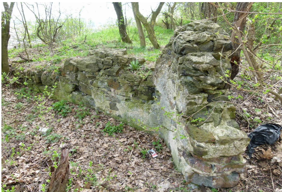
▲ Foto 22: Pozůstatky zdiva sousedního objektu – asi viničního lisu nebo obytného stavení.
