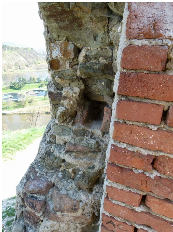
▲ Foto 08: Detail kapsy pro zasouvací závoru.
