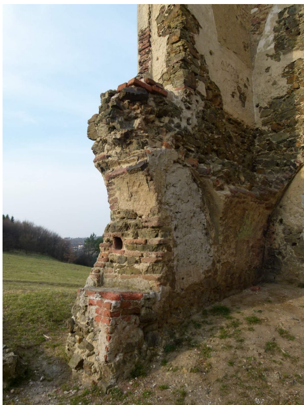
▲ Foto 11: Pohled na špaletu vstupních dveří z interiéru.
