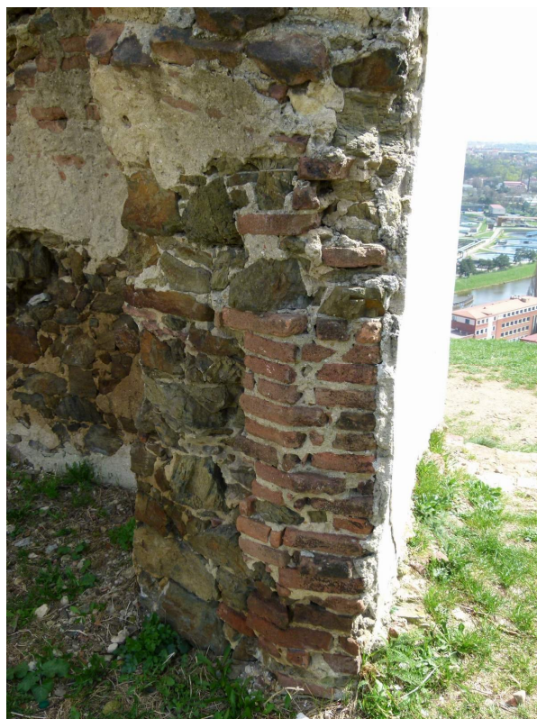
▲ Foto 19: Detail cihelné vyzdívky okraje jihozápadní zdi – snad pozůstatek špalety dveří.
