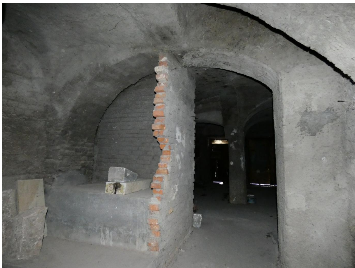
▲ Obr. 40: Klenební pas rozdělující místnost P03 v pohledu ze severu.
