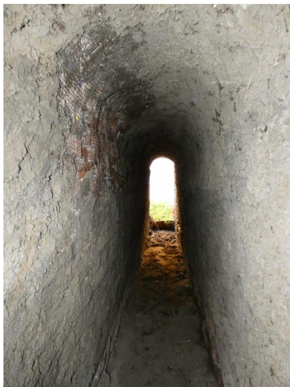
▲ Obr. 46: Chodba P06 při pohledu severním směrem.
