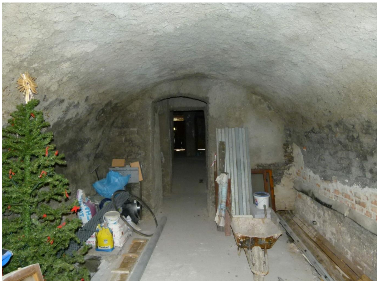
▲ Obr. 48: Místnost P07, zřejmě skladovací komora středověkého domu, zaklenutá gotickou cihelnou valenou klenbou.
