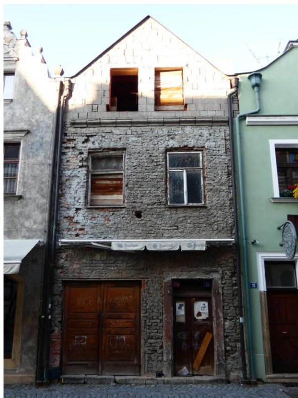
▲ Obr. 21: Jižní průčelí domu čp. 179.
