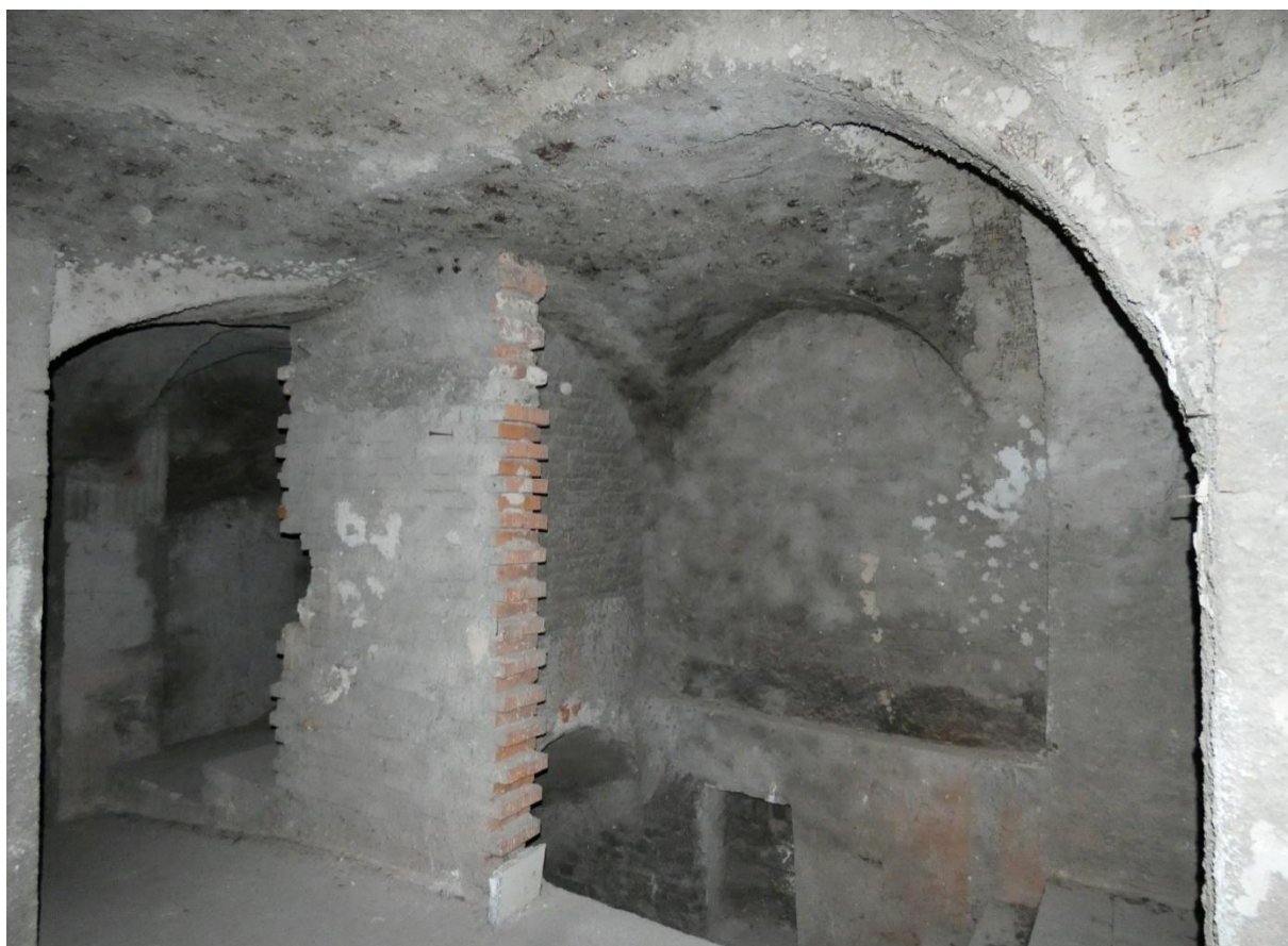
▲ Obr. 37: Pohled do východní části síně P03 se schodištěm do sklepů.
