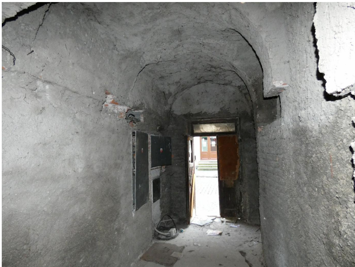
▲ Obr. 33: Pohled do místnosti P01 od severu směrem k hlavnímu vstupu.
