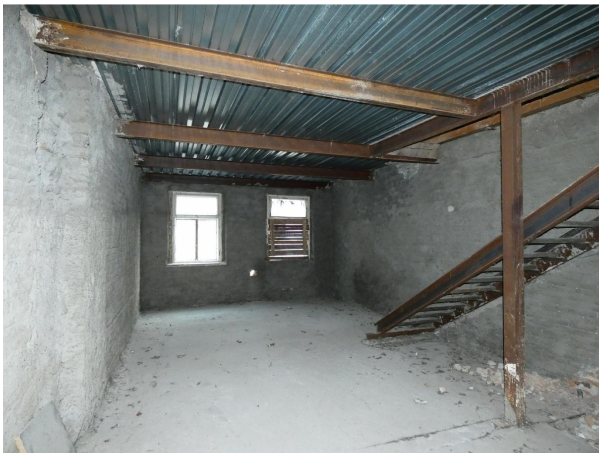
▲ Obr. 58: Pohled do místnosti 102 při jižním průčelí v pohledu ze severu.
