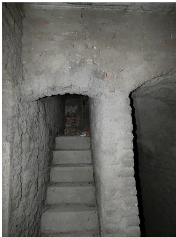
▲ Obr. 57: Nástup na schodiště do podkroví z prostoru podesty 101.
