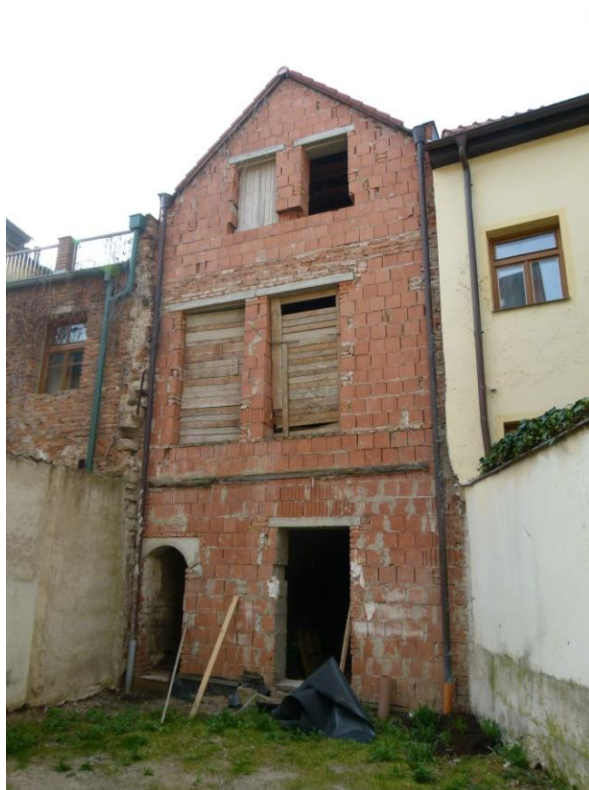
▲ Obr. 30: Severní novodobé průčelí domu.
