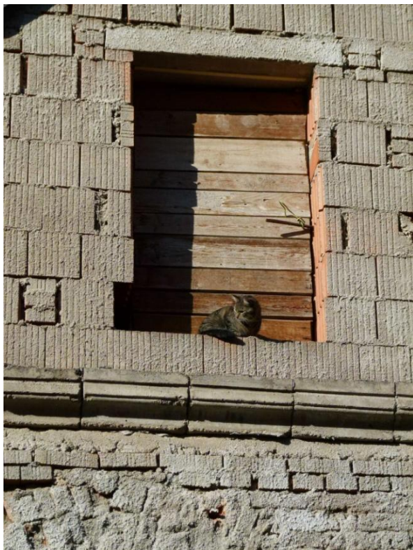
▲ Obr. 27: Novodobá betonová římsa jižního průčelí a nově vyzděný štít domu.
