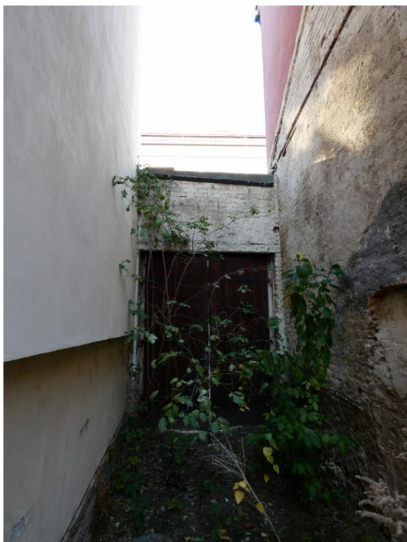
▲ Obr. 29: Průjezd do dvora na severní straně parcely.
