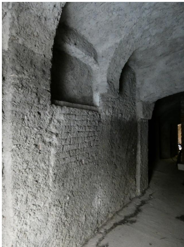
▲ Obr. 32: Zazděný průchod do místnosti P02 v mezitraktové zdi místnosti P01.
