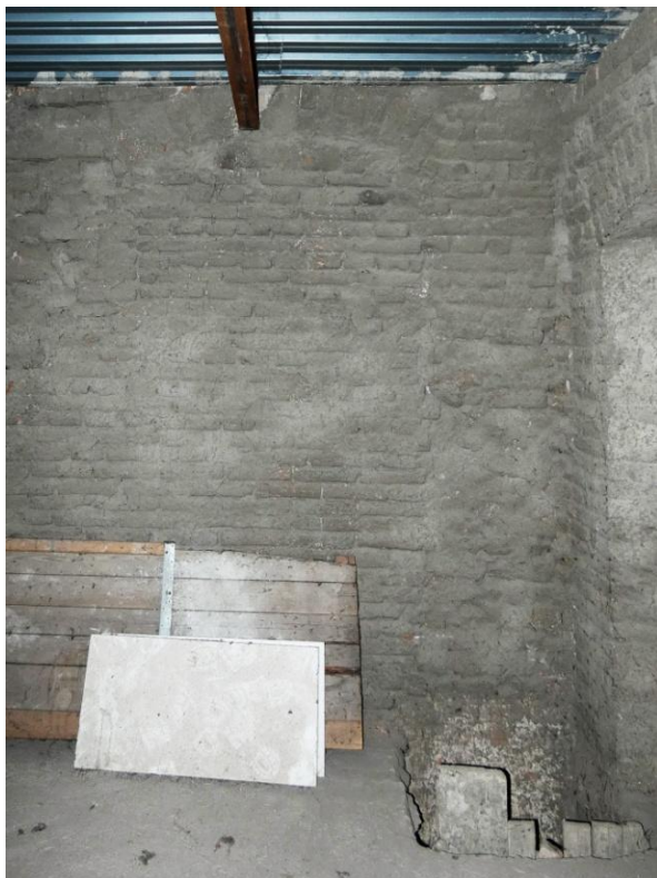
▲ Obr. 66: Zazděný klenutý výklenek ve východní stěně místnosti 103.
