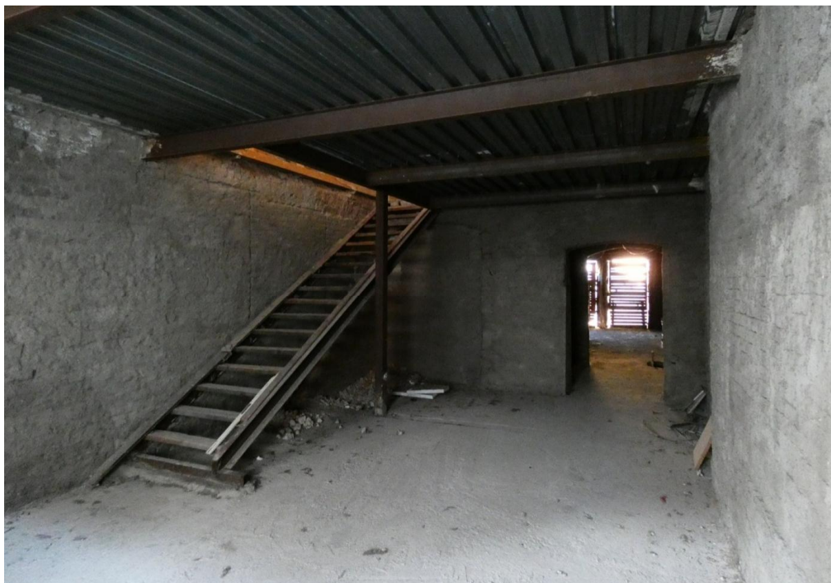
▲ Obr. 59: Pohled do místnosti 102 z jihu. Vlevo v severní stěně klenutá nika, vpravo klenutý průchod do prostoru schodišťové podesty 101.
