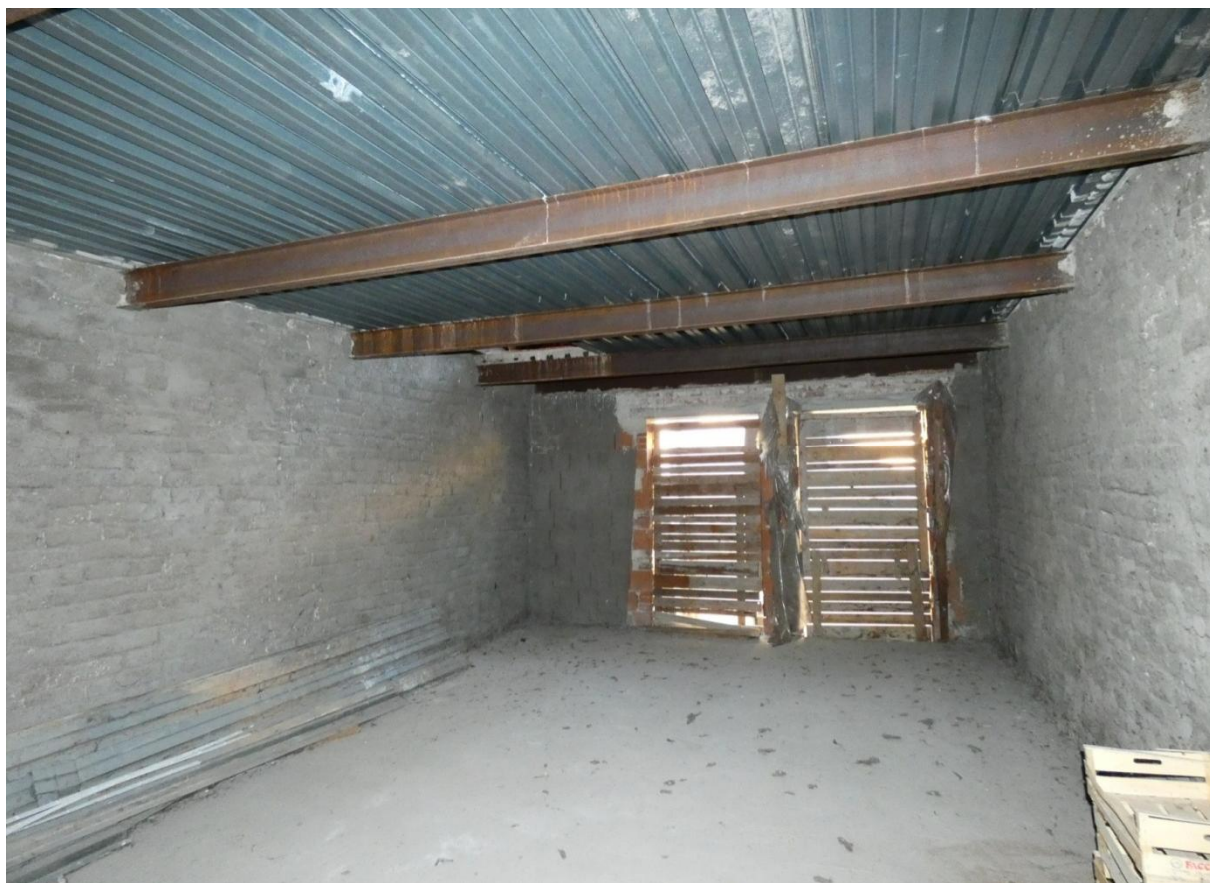
▲ Obr. 64: Podhled do místnosti 103 z jihu.
