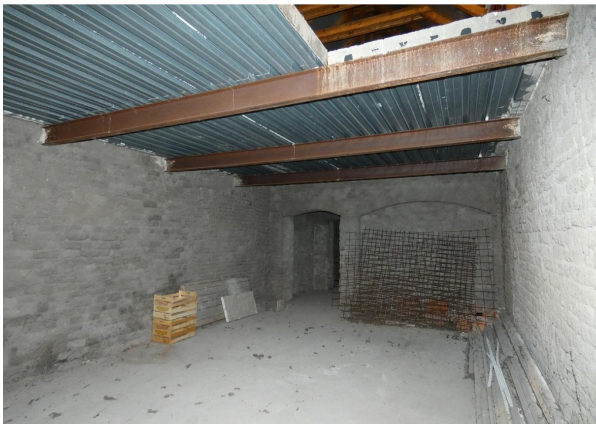
▲ Obr. 65: Pohled do místnosti 103 ze severu. Vlevo v severní stěně klenutý průchod do prostoru schodišťové podesty 101, vpravo klenutá nika.
