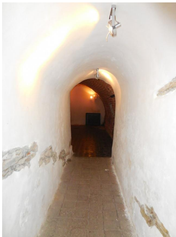
▲ Obr. 50: Sklepní chodba S02 při pohledu jižním směrem s ústím do sklepa S03.
