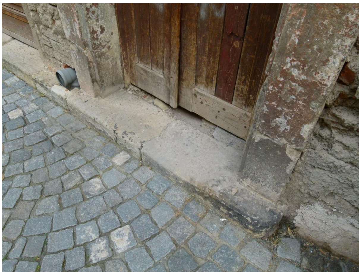
▲ Obr. 23: Kamenný schod před jižním průčelím domu.
