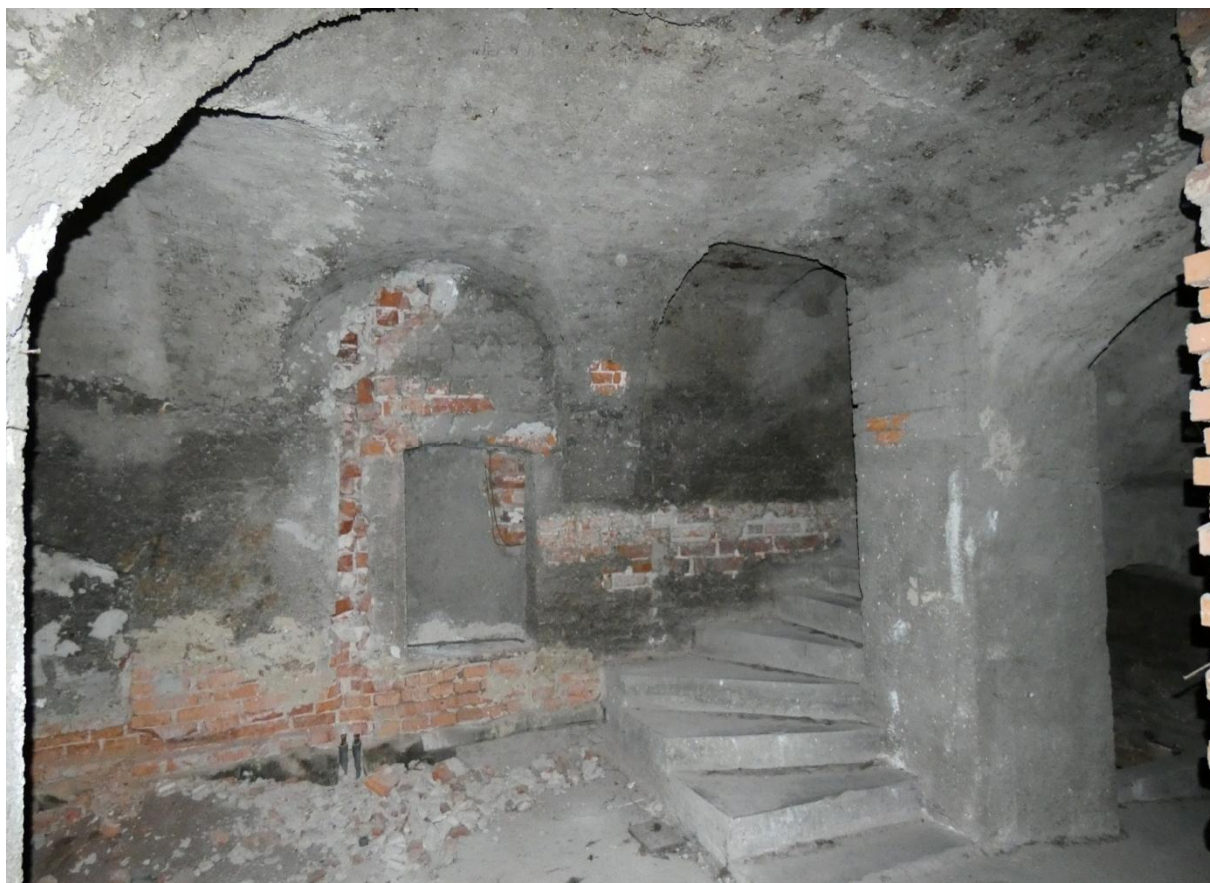
▲ Obr. 36: Síň P03 se schodištěm do patra a výklenkem v západní meziparcelní zdi.
