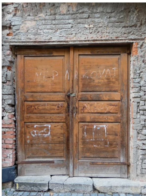
▲ Obr. 25: Vrata do domu se starším záclenkem pro kamenné ostění z roku 1876.
