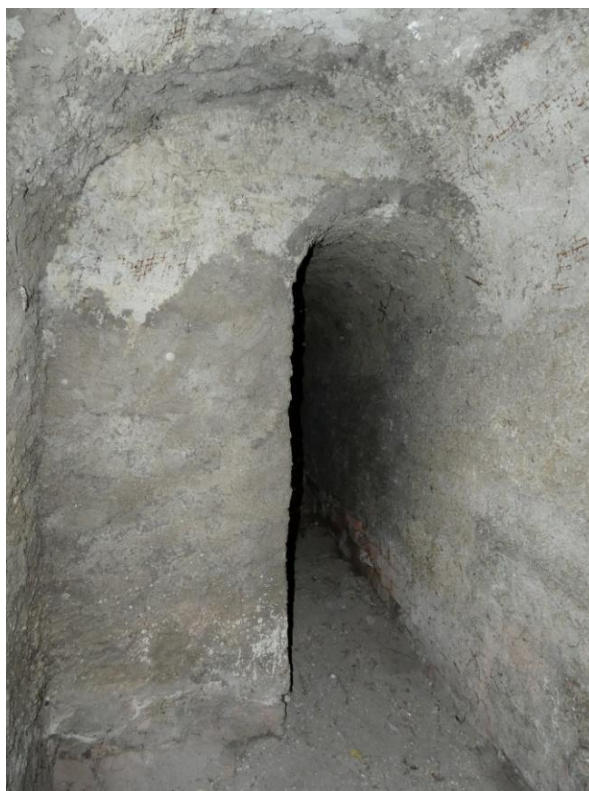
▲ Obr. 45: Průchod z místnosti P05 do úzké chodby P06.
