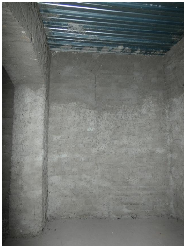
▲ Obr. 55: Prostor schodišťové podesty 101 se zazednou částí klenutého výklenku ve východní stěně.
