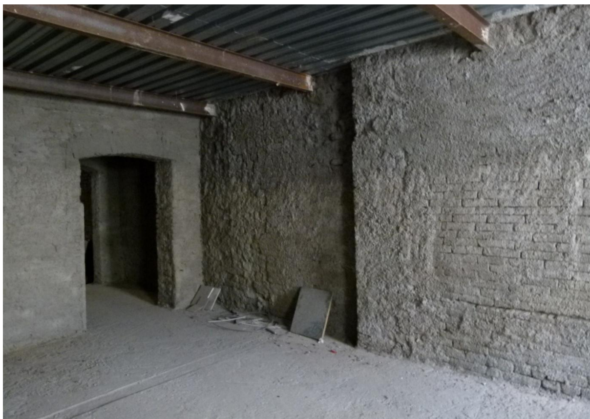
▲ Obr. 60: Pohled na východní stěnu místnosti 102 s odsazením v místě někdejšího průlezného komínu a navazující dělicí příčky.
