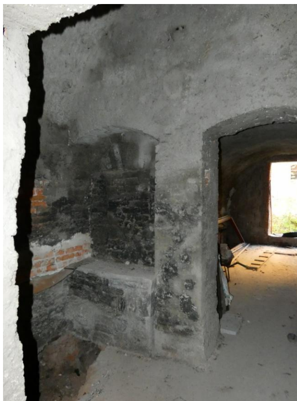
▲ Obr. 43: Místnost P04 identifikovaná jako černá kuchyně s pozůstatkem topeniště.
