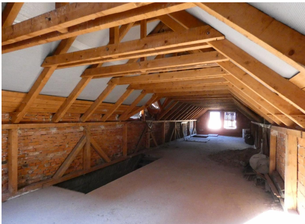
▲ Obr. 68: Pohled do prostoru krovu zhotoveného v roce 1998 s nadezdívkou tvořenou zčásti novodobými děrovanými cihlami a zčásti druhotně použitými cihlami pocházejícími pravděpodobně ze zbourané dělicí stěny nynější místnosti 103.
