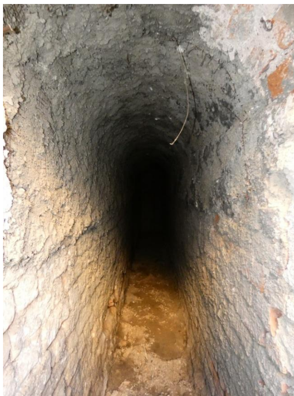
▲ Obr. 47: Chodba P06 při pohledu jižním směrem.
