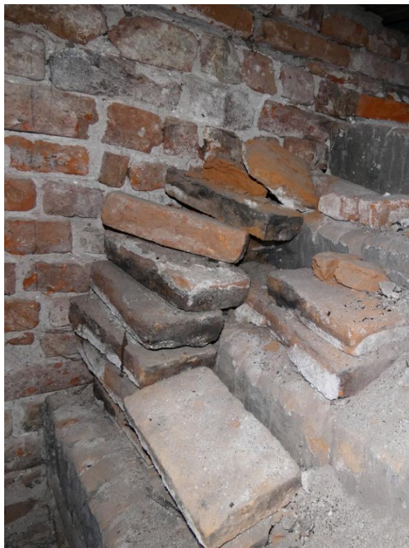
▲ Obr. 67: Zbytek schodiště do podkrovní s cihelnými stupni.
