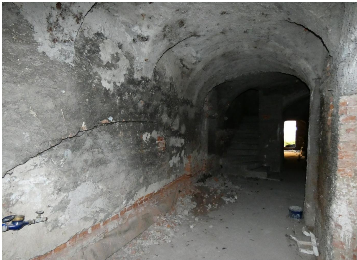
▲ Obr. 35: Místnost P02 od jihu. Vlevo arkáda v západní meziparcelní zdi.
