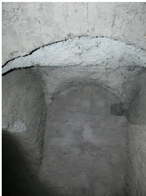
▲ Obr. 42: Klenba nad mezipodestou schodiště do patra.
