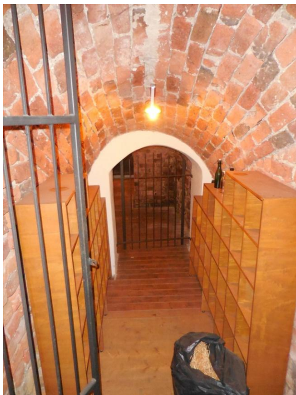
▲ Obr. 54: Stoupající cihelná valená klenba sklepa S04 v pohledu severním směrem.
