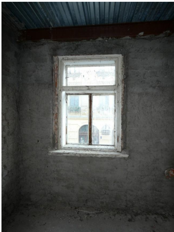
▲ Obr. 61: Špaleta okna s dodatečně zazděným původně ustoupeným parapetem v místnosti 102.
