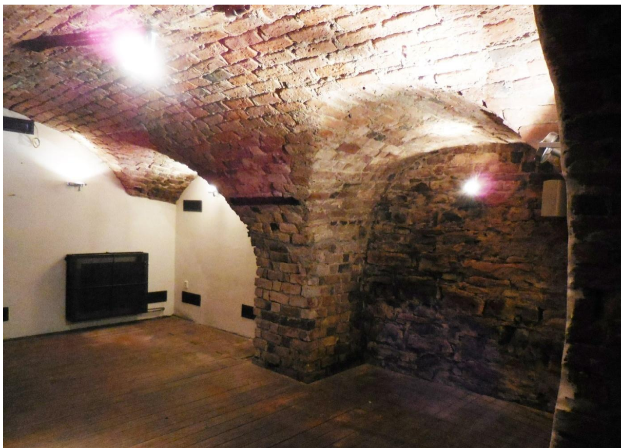
▲ Obr. 52: Sklep S05 zaklenutý gotickou cihelnou klenbou s mohutným pilířem a klenebními výsečemi. Pohled na východní stěnu vyzděnou převážně z lomového kamene.
