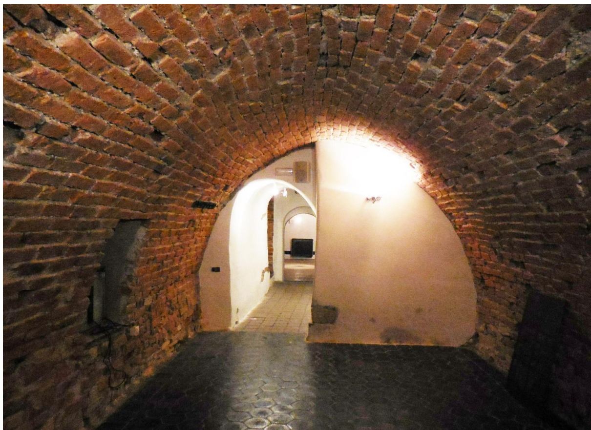
▲ Obr. 51: Sklep S03 zaklenutý gotickou cihelnou valenou klenbou s lehce hrotitým profilem.
