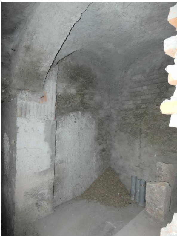
▲ Obr. 38: Severovýchodní část síně P03 se zazděným průchodem do místnosti P05.
