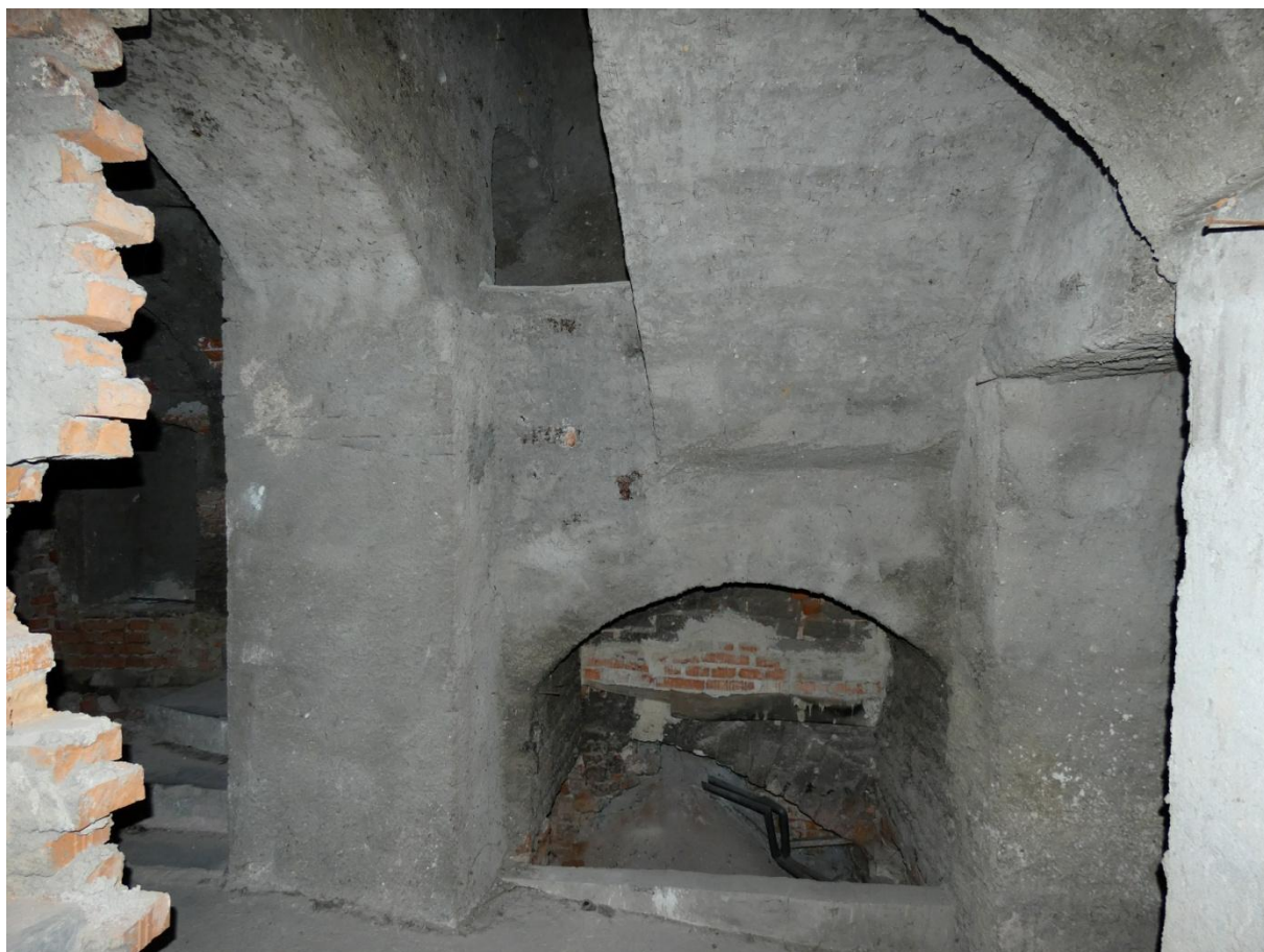
▲ Obr. 41: Klenutí schodiště do patra v síni P03 se starším záklenkem v dolní partii.
