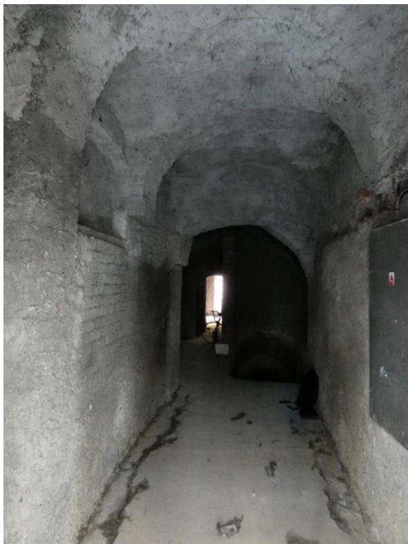
▲ Obr. 31: Místnost P01 s valenou klenbou s pětibokými výsečemi v pohledu od vstupu.
