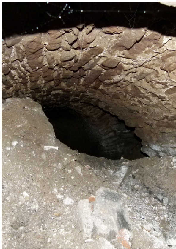
▲ Obr. 70: Průhled gotickým portálem do zasypaného sklepa S12.
