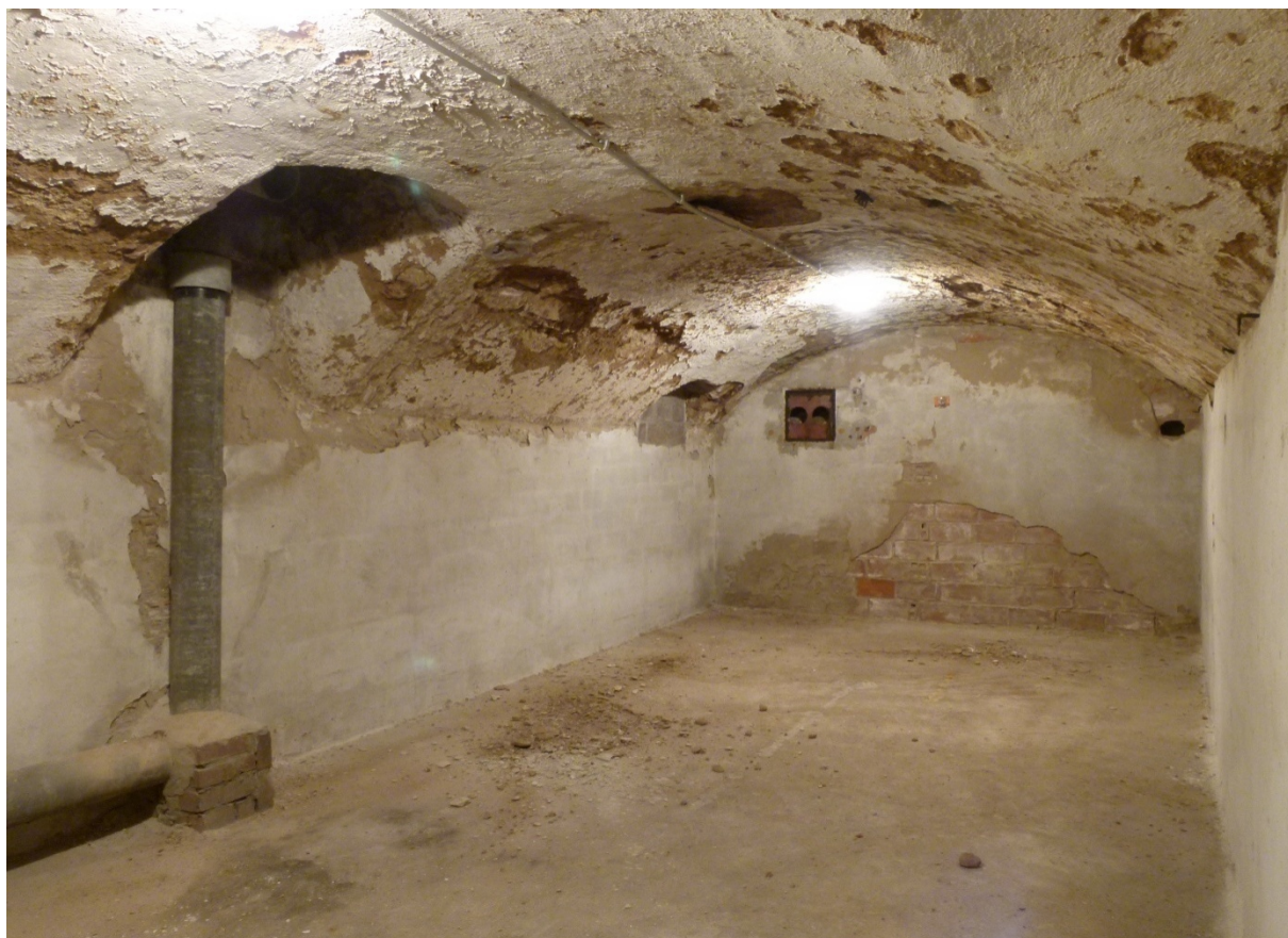
▲ Obr. 61: Pohled od východu na sklep S04 zaklenutý valenou klenbou, který je po obvodu opatřen přízdívkou z dutých cihel, vlevo zřejmě vyústění šíje z počátku 20. století.
