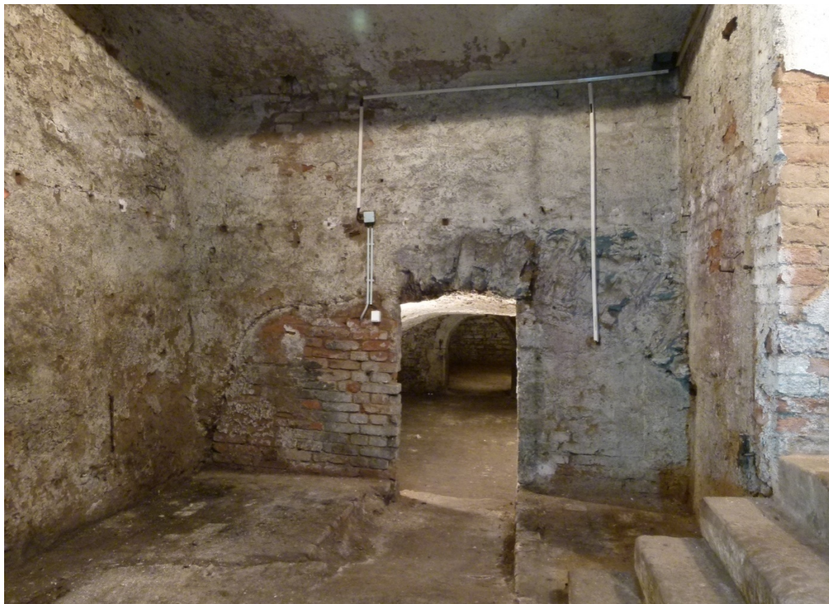
▲ Obr. 58: Pohled na východní stěnu sklepa S02.
