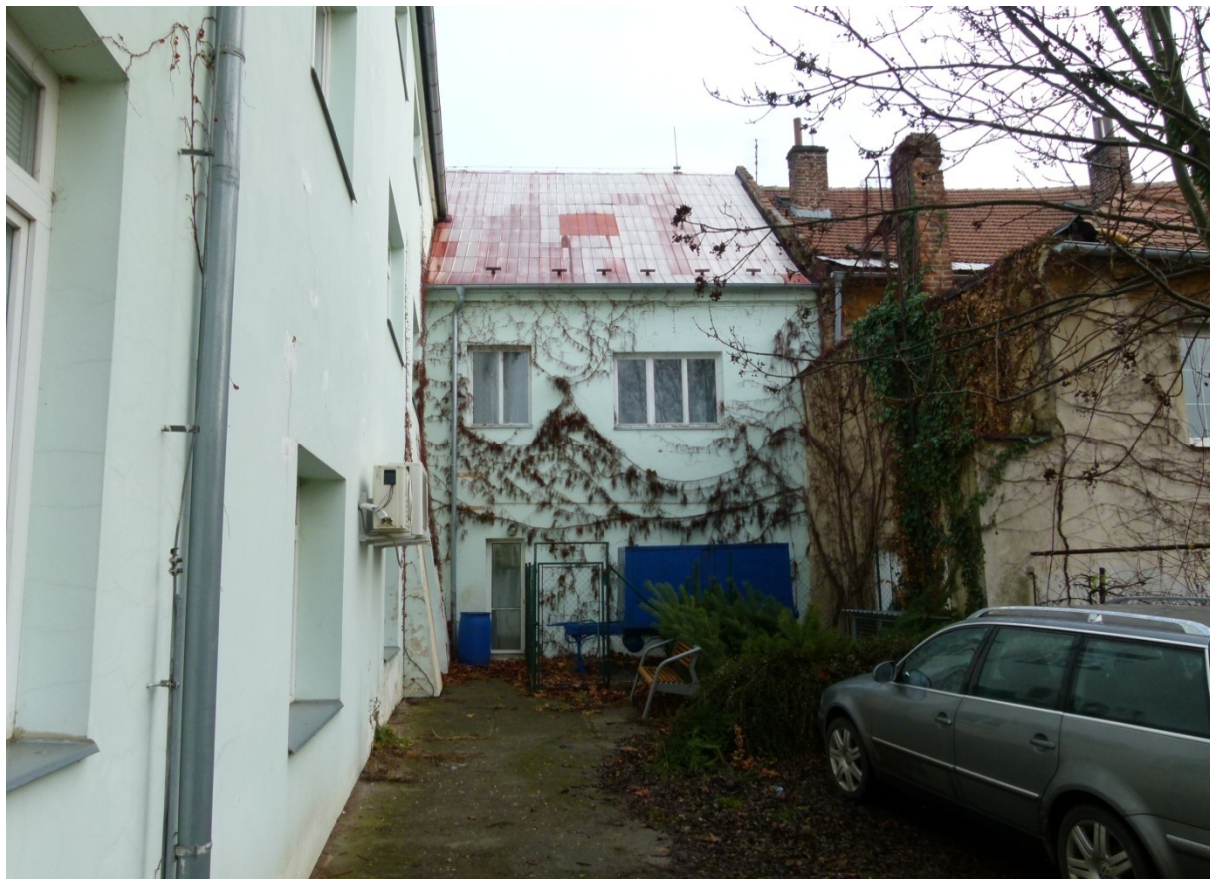
▲ Obr. 40: Pohled na západní průčelí východního křídla. Vlevo opěráky na jižní fasádě přístavku mezi oběma křídly budovy.
