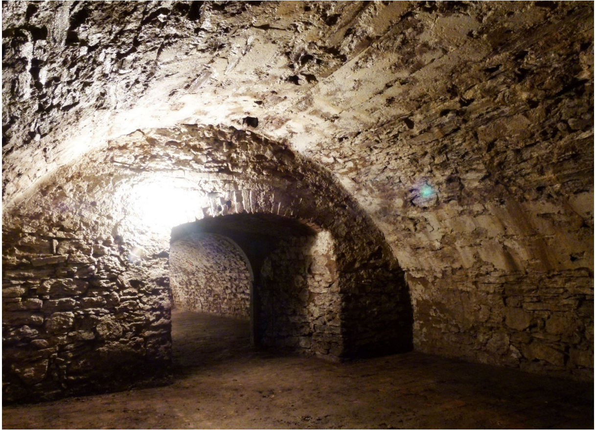
▲ Obr. 65: Průhled sklepem S07 od východu. Na klenbě jsou patrné otisky bednění.
