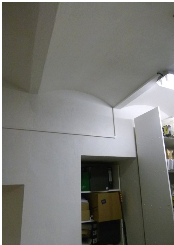
▲ Obr. 55: Plochá segmentová klenba do travers v místnosti P20.
