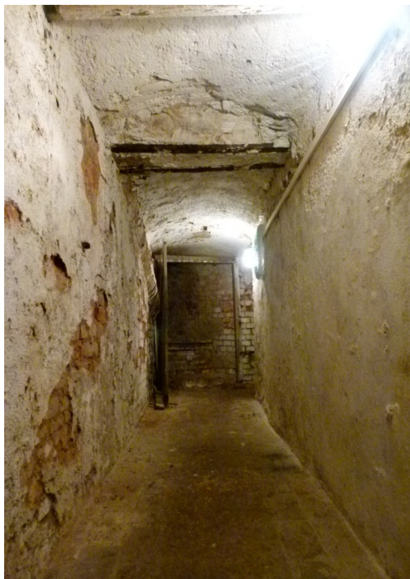
▲ Obr. 56: Sklepní chodba S01.
