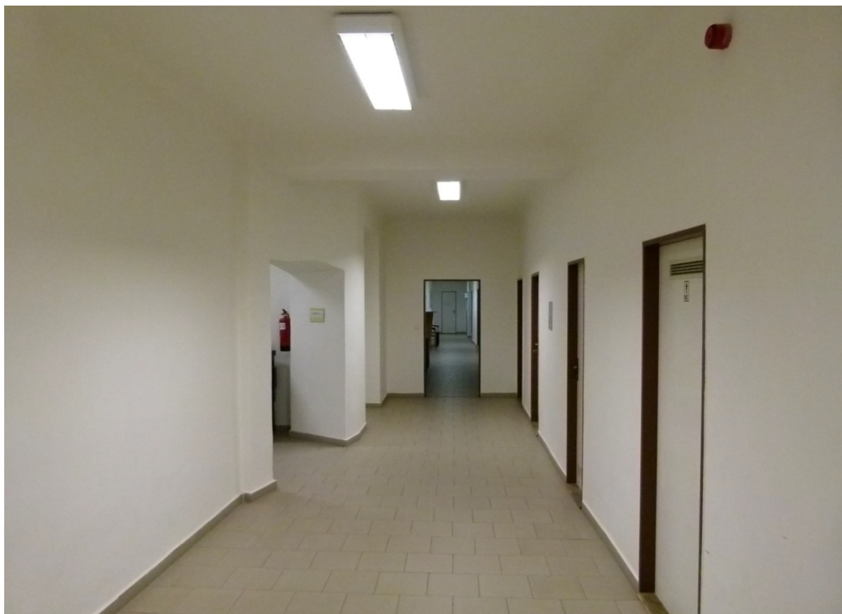
▲ Obr. 77: Průhled chodbou 115 od východu. Vlevo klenutý průchod do místnosti 117.
