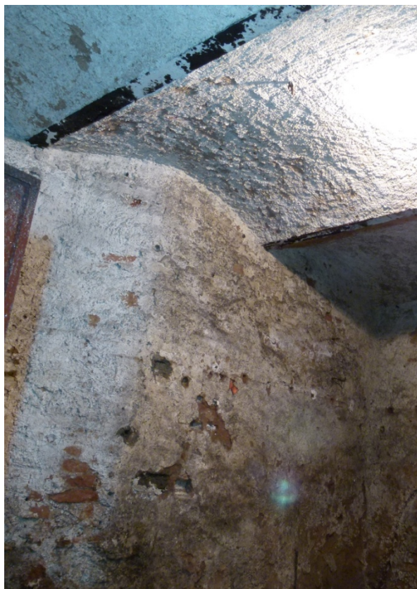
▲ Obr. 57: Plochá segmentová klenba do travers ve sklepi S02.
