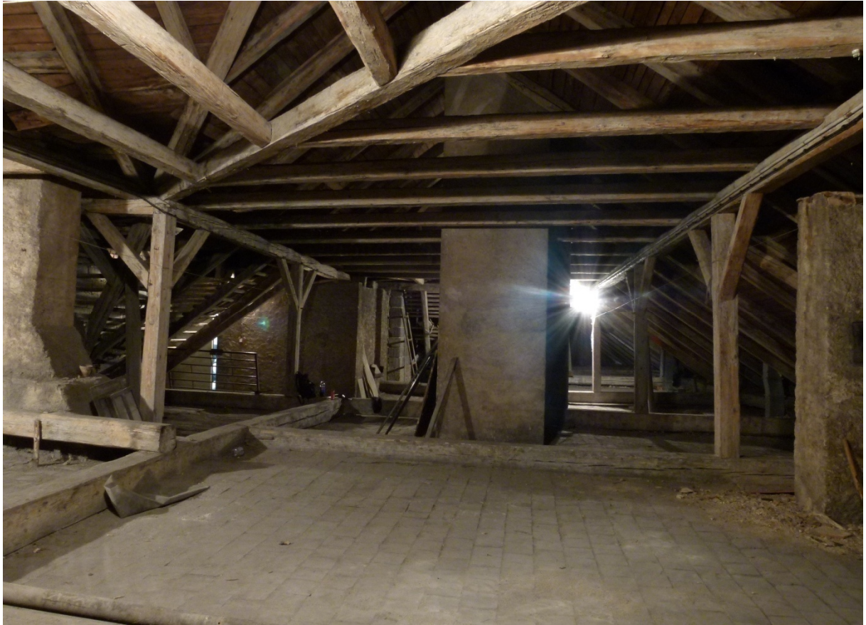
▲ Obr. 81: Pohled do krovu hambálkové konstrukce nad severním křídlem od východu.
