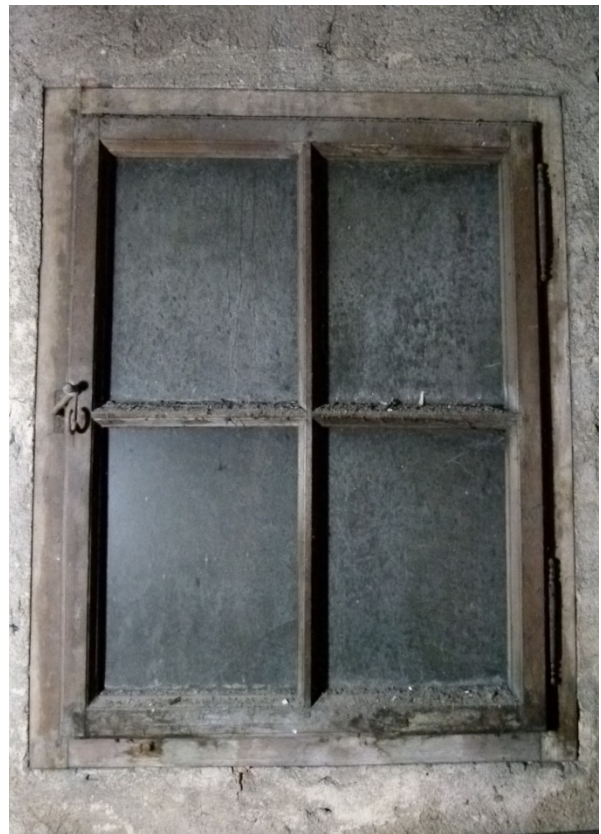
▲ Obr. 83: Detail okna světlíku.
