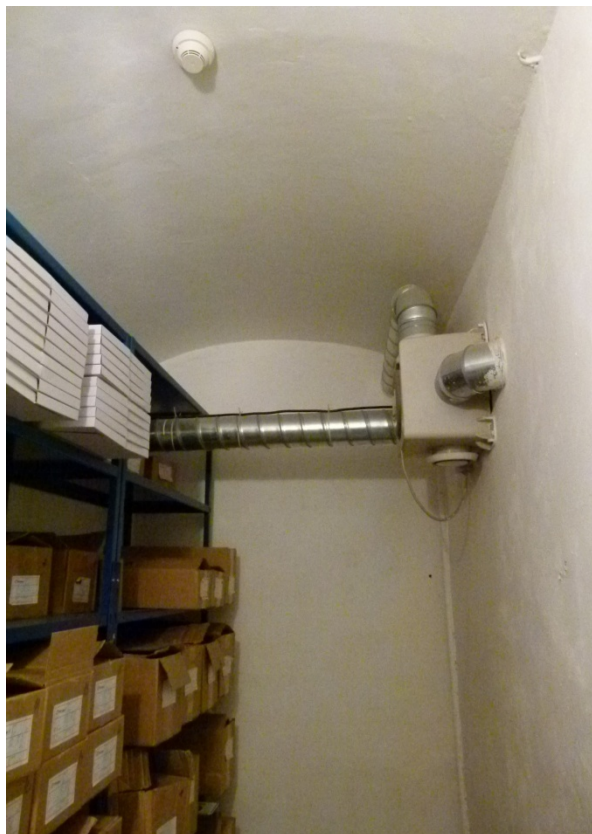
▲ Obr. 54: Segmentová valená klenba místnosti P18.
