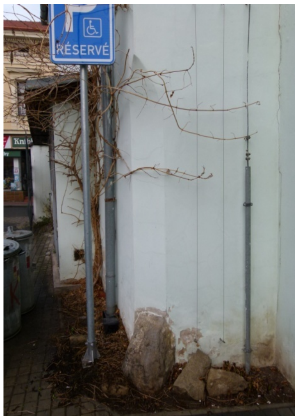
▲ Obr. 38: Okosené jihozápadní nároží severního křídla s kamenným patníkem.
