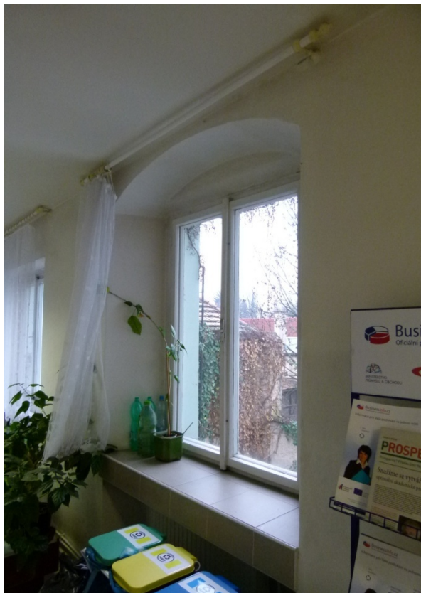
▲ Obr. 73: Detail okna se segmentovým záklenkem v chodbě 102.
