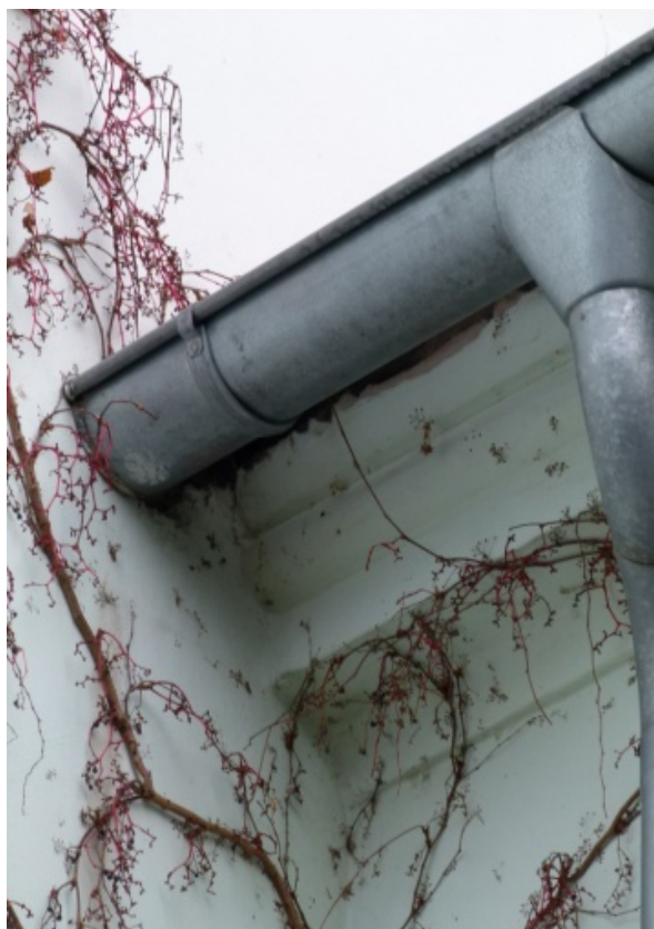
▲ Obr. 39: Detail hlavní římsy západního průčelí východního křídla.
