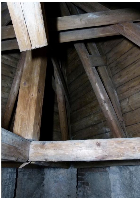
▲ Obr. 90: Detail krovu střechy věžice se sružovými krokvi.
