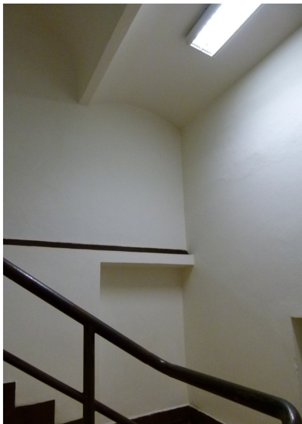
▲ Obr. 72: Schodišťová podesta zaklenutá segmentovou klenbou do traversy.
