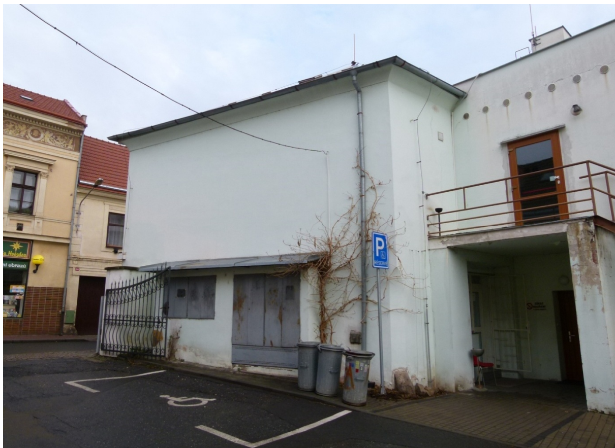
▲ Obr. 37: Pohled z prostoru dvora na západní průčelí severního křídla.
