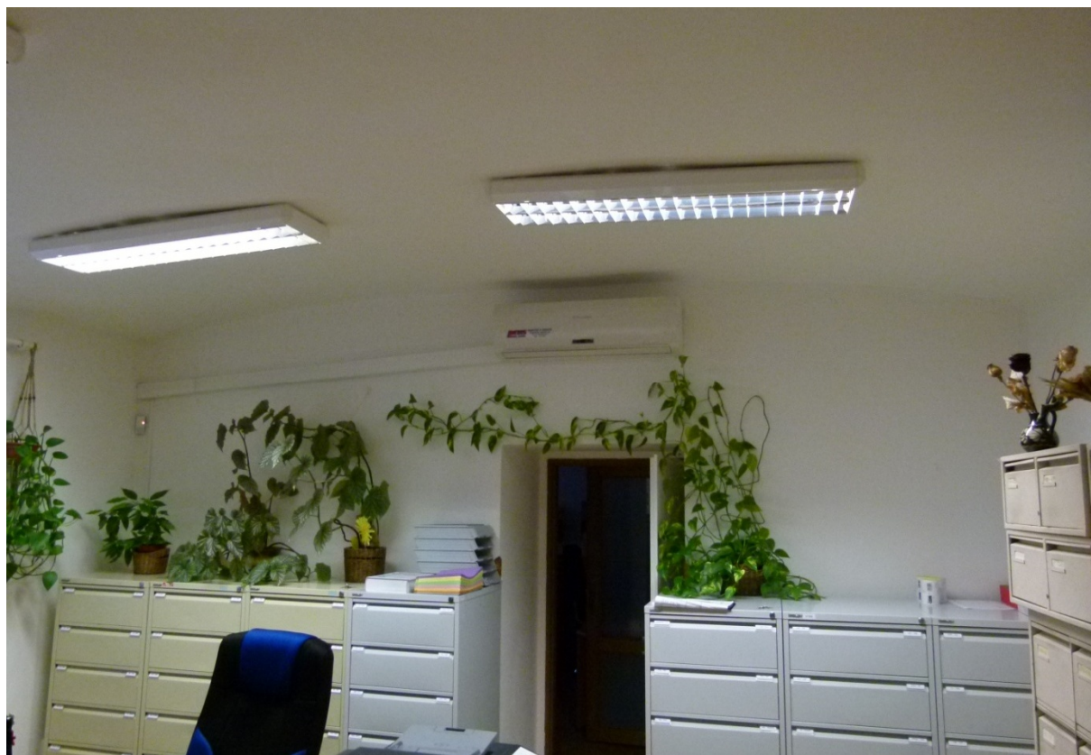
▲ Obr. 47: Místnost P08 zaklenutá velmi plochou segmentovou valenou klenbou.
