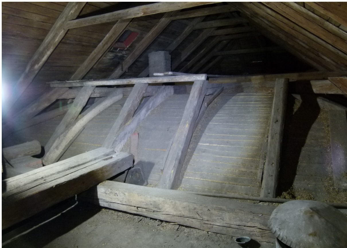
▲ Obr. 87: Pohled do západní části hambalkového krovu nad severním křídlem s nosnou konstrukcí falešné klenby.
