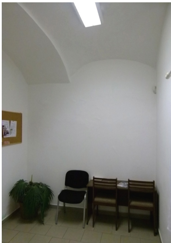
▲ Obr. 45: Pohled do místnosti P04 zaklenuté plackovou klenbou.
