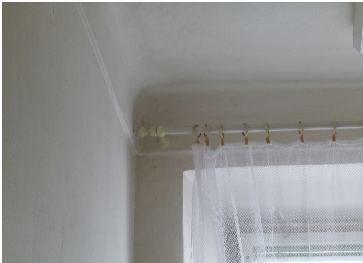
▲ Obr. 78: Detail fabionu stropu v místnosti 120.
