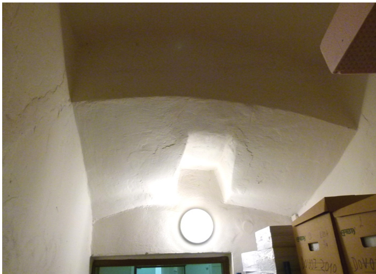
▲ Obr. 53: Náběh stoupající segmentové klenby v místnosti P17 po zrušeném schodišti.
