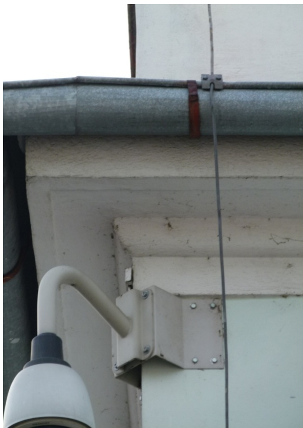
▲ Obr. 35: Detail hlavní římsy na severovýchodním nároží.
