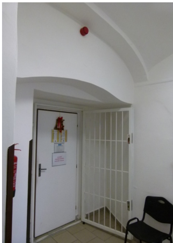
▲ Obr. 44: Východní stěna místnosti P03.
