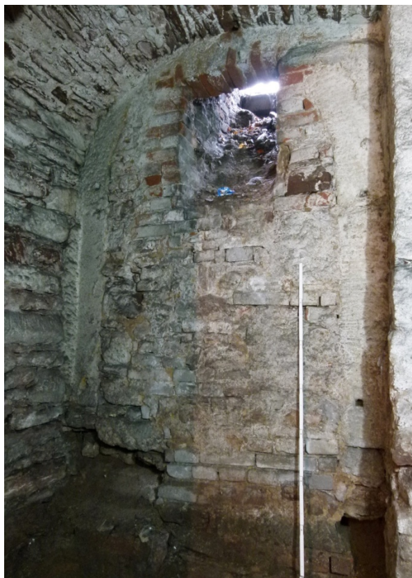
▲ Obr. 69: Pohled do severovýchodní části sklepa S09 se zazděným portálem.
