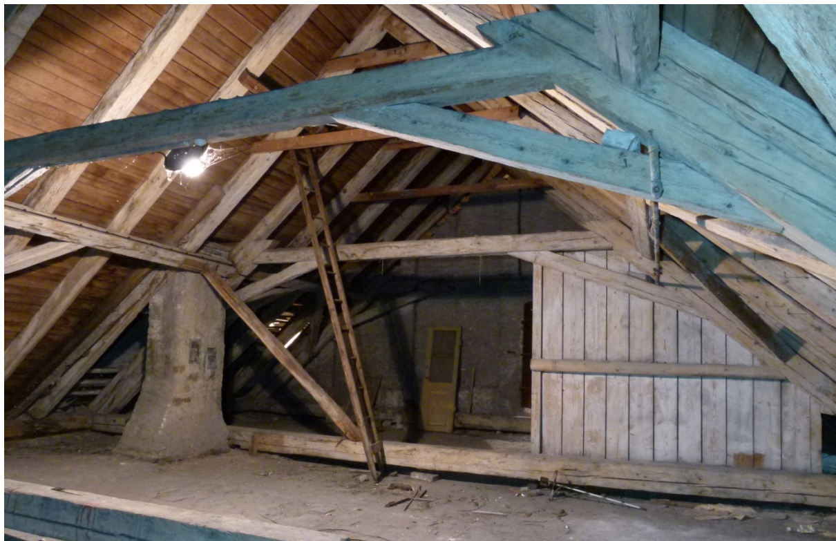
▲ Obr. 92: Tzv. Rankův krov nad jižní částí východního křídla.
