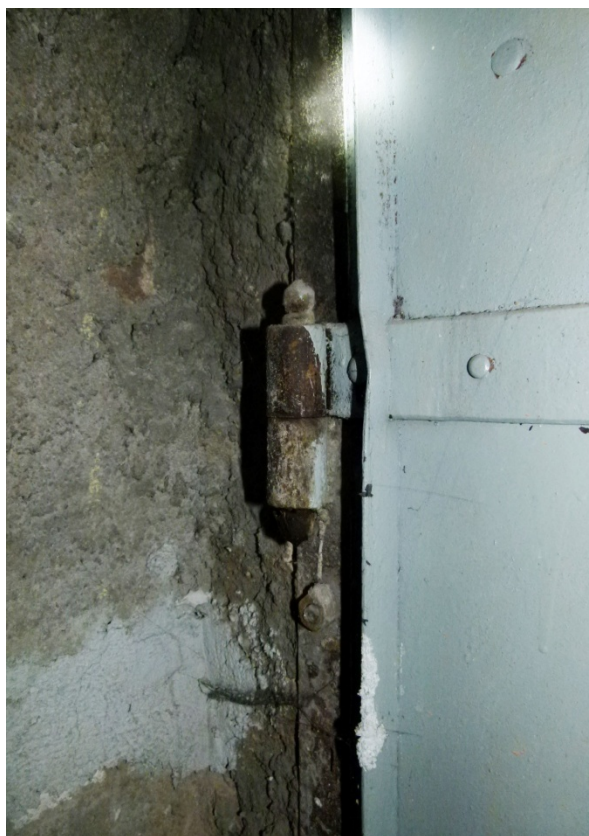
▲ Obr. 80: Detail závěsu železných dveří do prostoru krovu.
