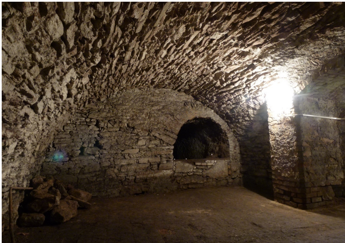
▲ Obr. 67: Průhled sklepem S09 od východu. Vpravo vyústění sklepní chodby S08, vpředu průchod do sklepa S10.
