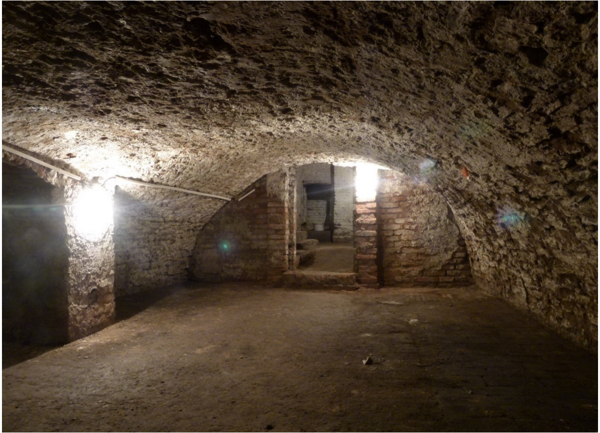
▲ Obr. 63: Průhled gotickým valeně zaklenutým sklepem S06 od východu.
