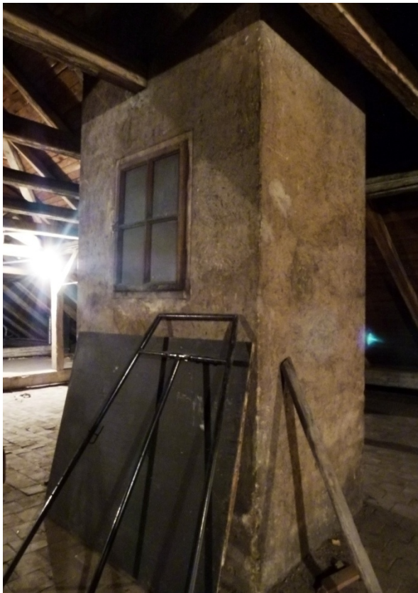
▲ Obr. 82: Těleso světlíku v prostoru krovu.
