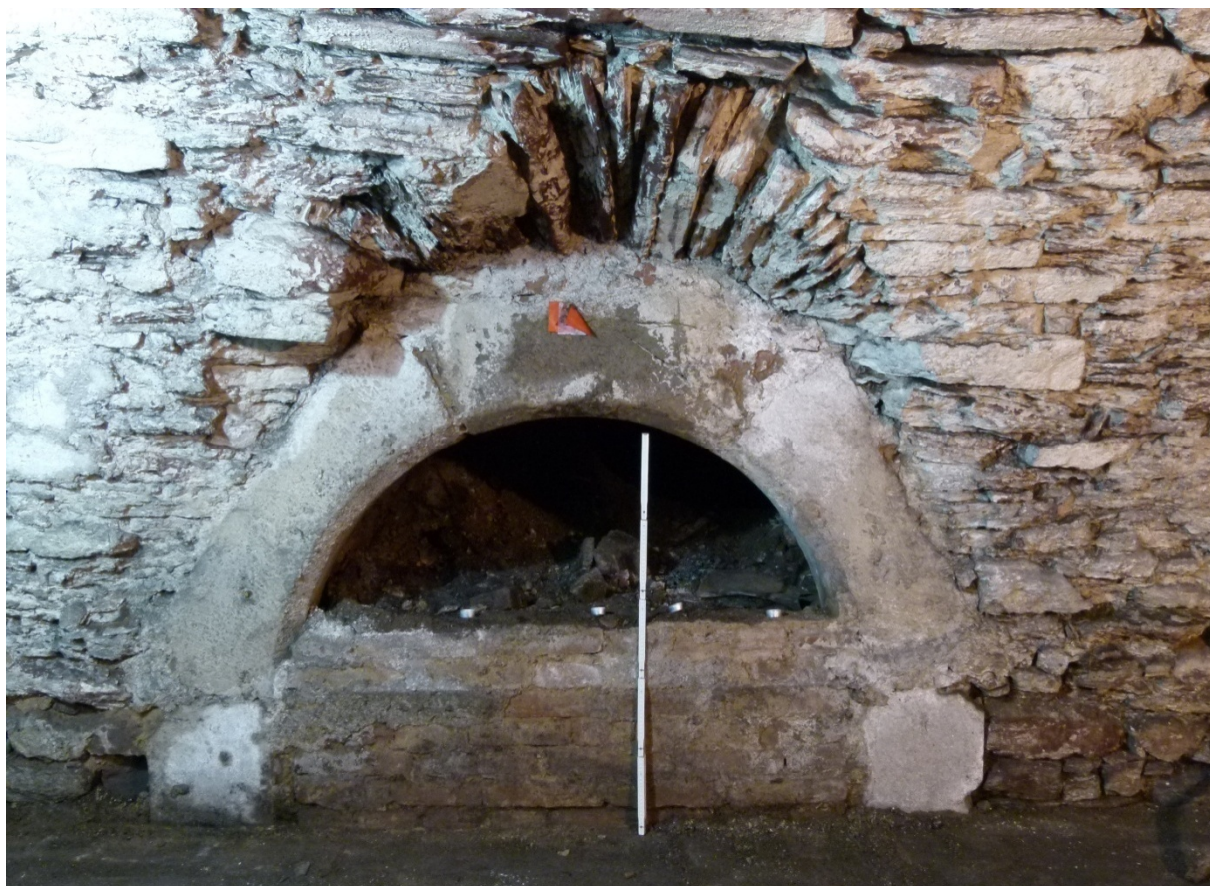
▲ Obr. 68: Detailní pohled na gotický portál sklepu S09.
