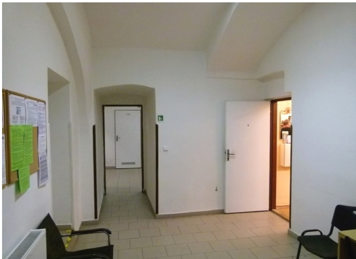
▲ Obr. 43: Pohled do místnosti P02 zaklenuté segmentovou valenou klenbou s pasy.
