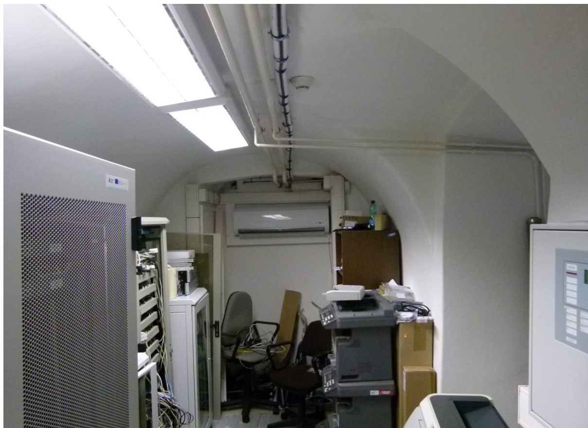
▲ Obr. 52: Pohled do místnosti P14 zaklenuté valenou klenbou s pětibokými výsečemi.
