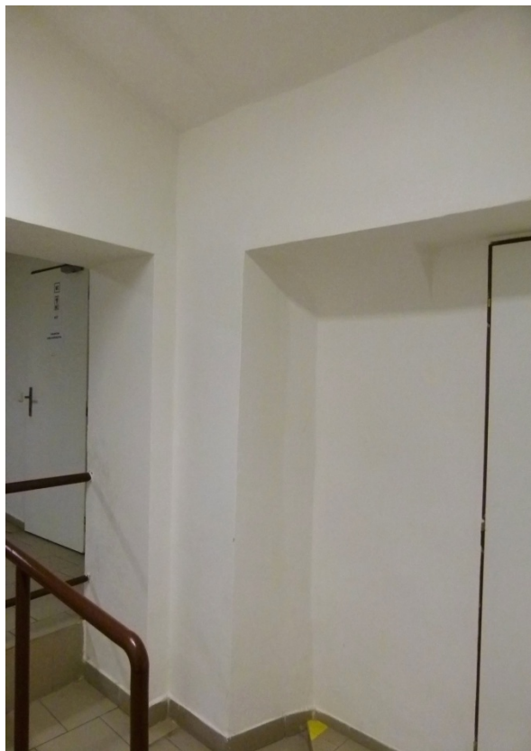
▲ Obr. 49: Místnost P19 s fragmentem náběhu klenby vpravo v nice.
