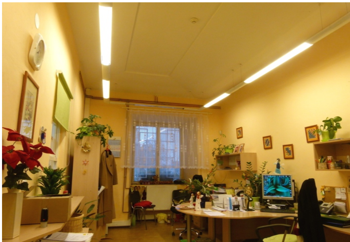
▲ Obr. 46: Místnost P04 s plochou segmentovou klenbou do travers v provedení neckového tvaru s obdélným vpadlým zrcadlem, bývalá jídelna hostince.
