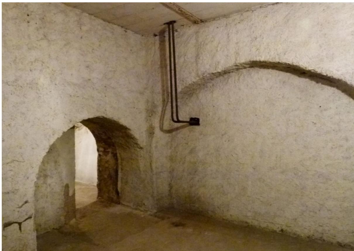
▲ Obr. 62: Pohled na severozápadní kout sklepa S05 patrně s pozůstatkem starší klenby.
