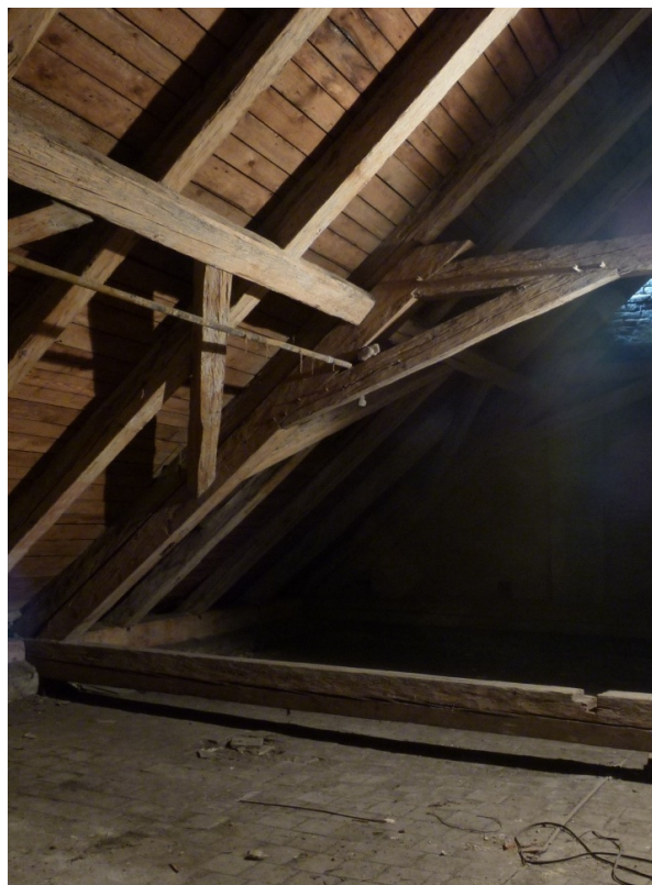
▲ Obr. 93: Detail plné vazby tzv. Rankova krovu nad jižní částí východního křídla. Sloupky šikmých stolic doplněné o rozpěry jsou nasazeny na vazný trám a nesou vaznice. Podélné zavětrování tvoří pásy a krokve jsou opřené o vaznice.
