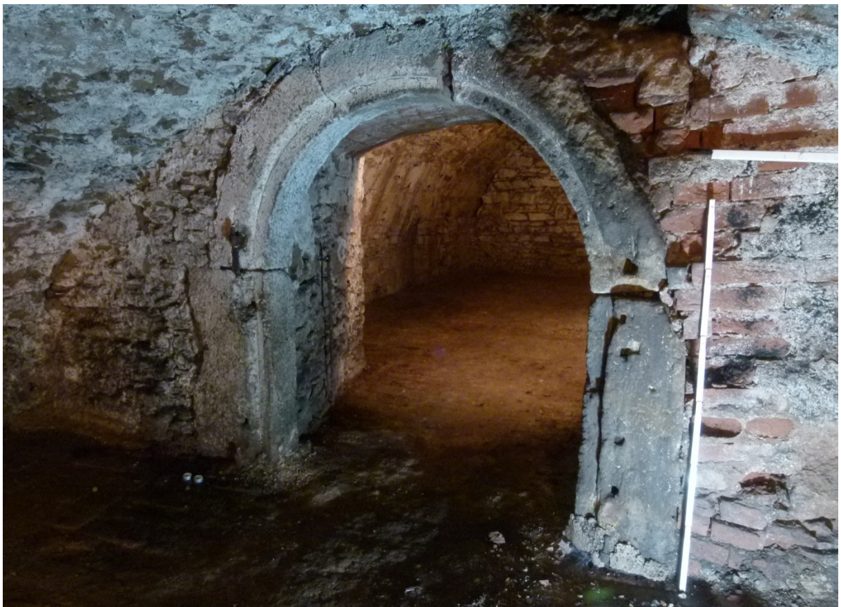
▲ Obr. 64: Detailní pohled na kamenný portál ve sklepě S06.
