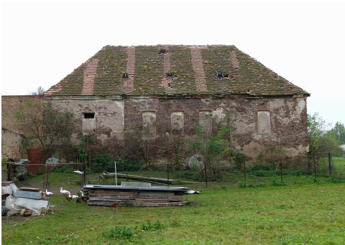
▲ Severní fasáda barokní sýpky s osovým rizalitem a slepými okny.
