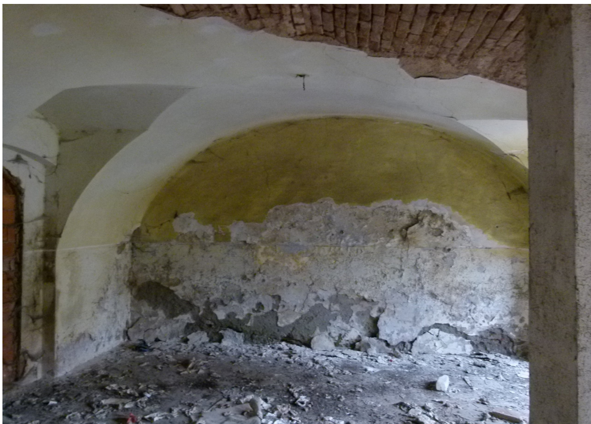
▲ Místnost P04 zaklenutá barokní valenou klenbou s pětibokými výsečemi.
