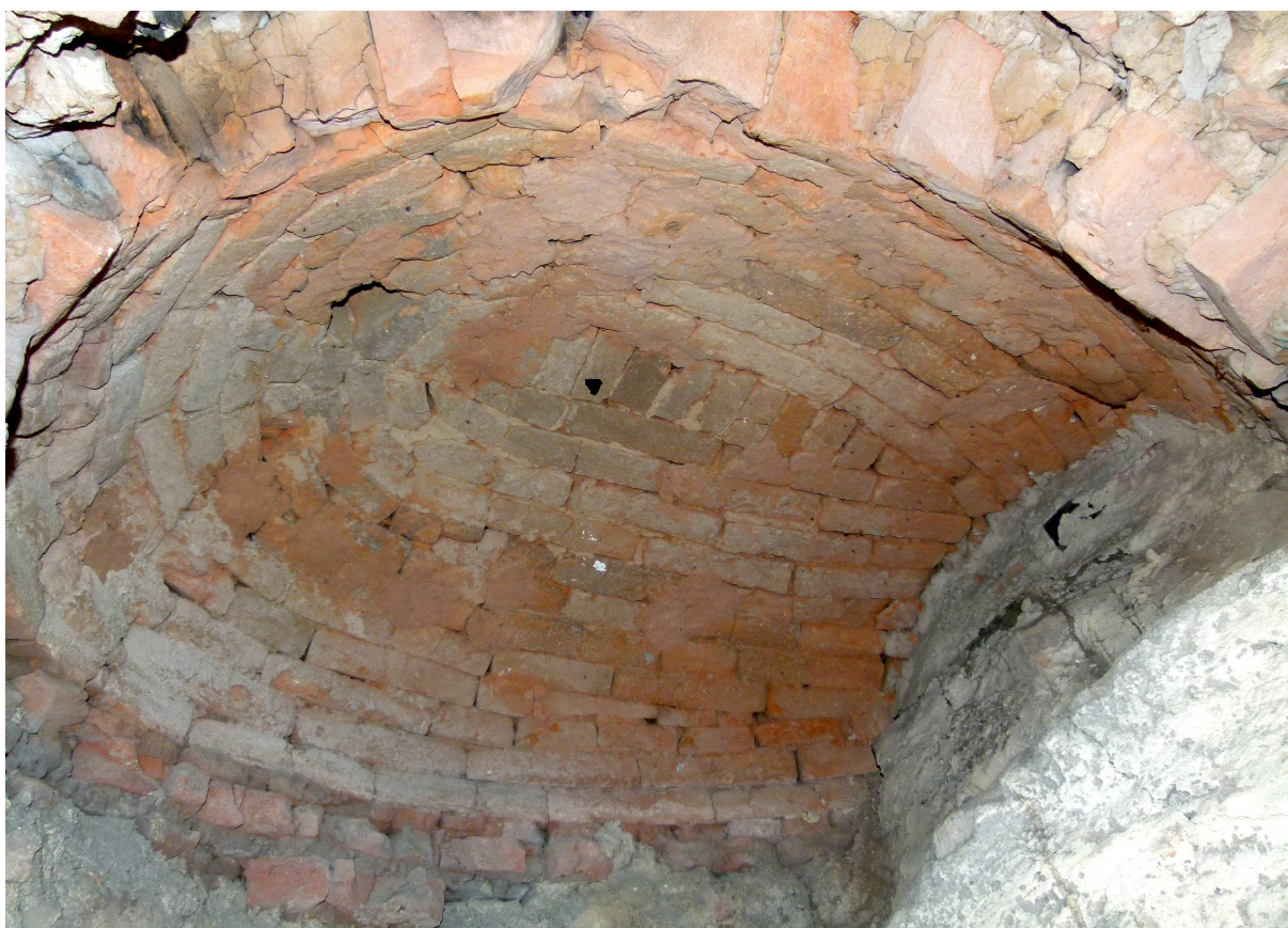
▲ Klasicistní pec vestavěná pod barokní schodišťovou podestu.
