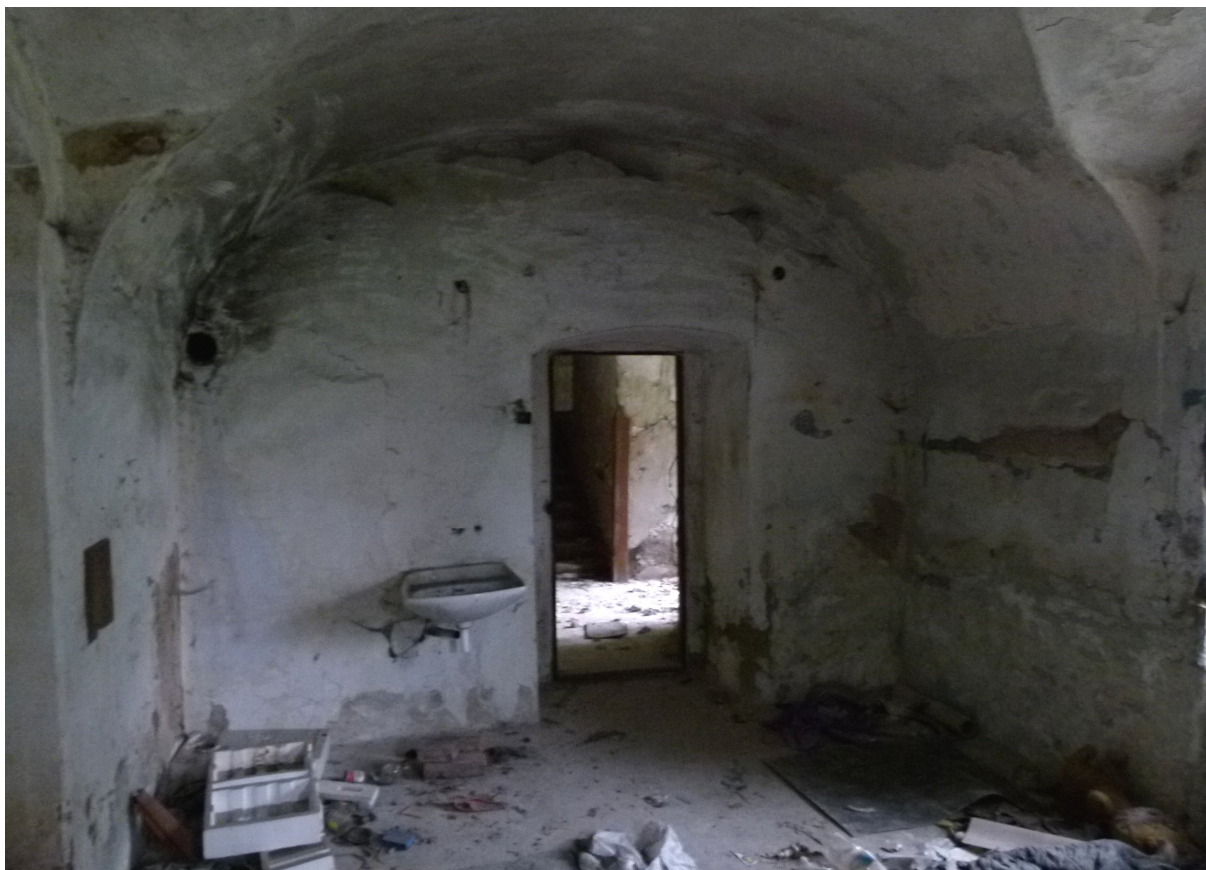
▲ Místnost P05 zaklenutá barokní valenou klenbou.
