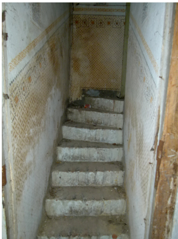
▲ Spojovací schodiště P10.
