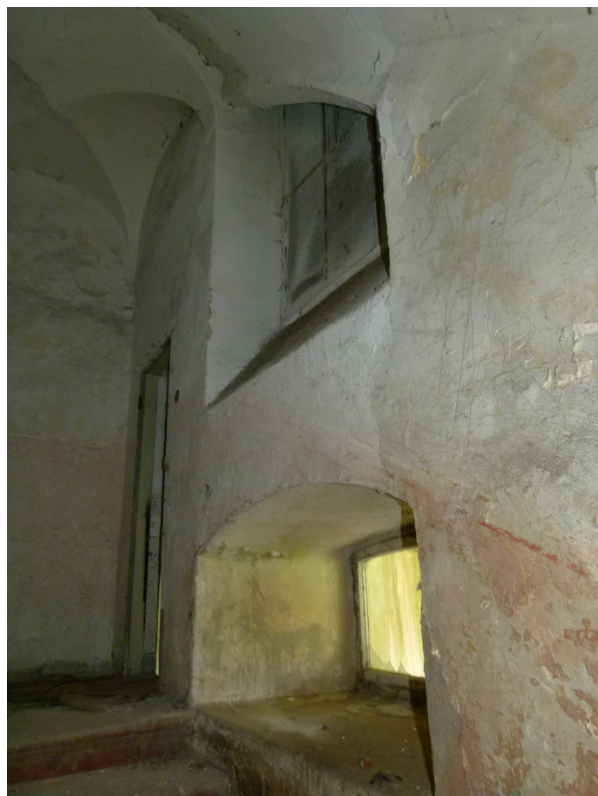
▲ Pohled na jižní stěnu schodiště s průchodem na spojovací schodiště P10.
