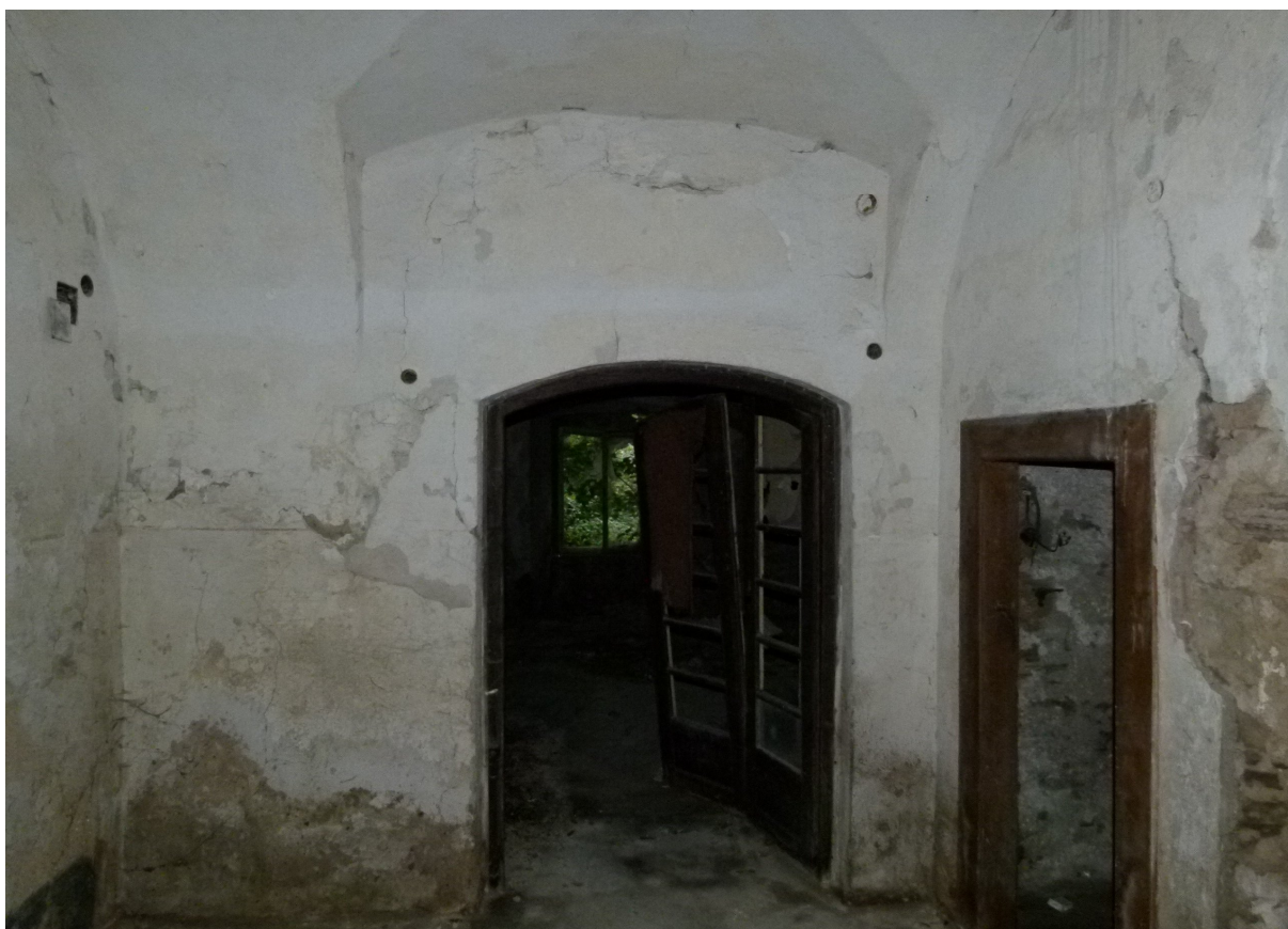
▲ Síň P02 zaklenutá stlačenou valenou klenbou s pětibokými výsečemi.
