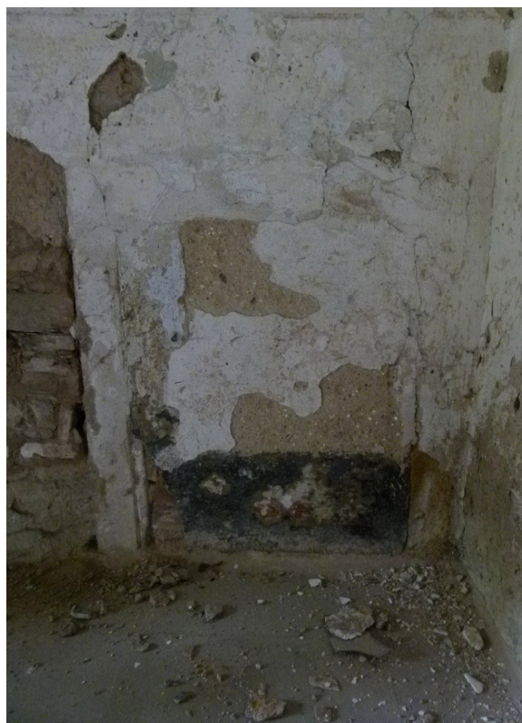
▲ Otvor pro obsluhu kamen v místnosti P02 s kamenným ostěním.
