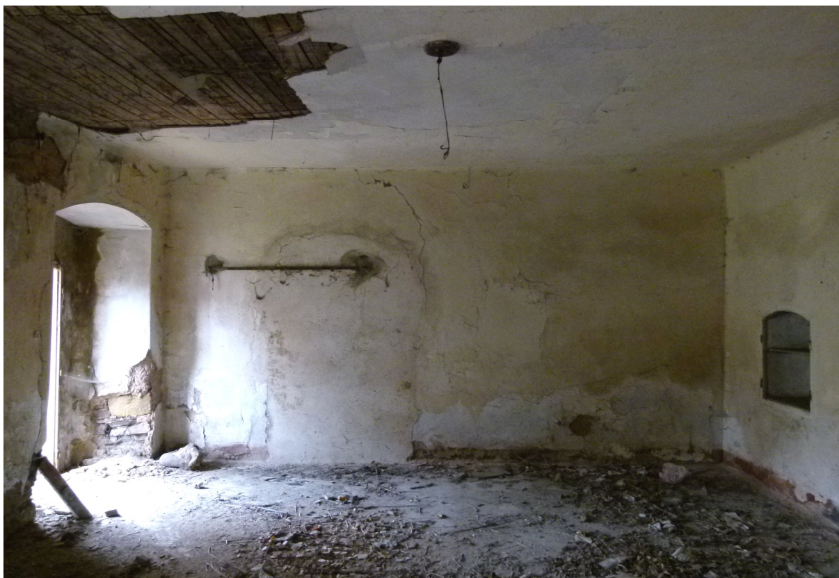
▲ Plochostropá místnost P03 se zazděným průchodem a otvorem pro odvod kouře z kamen. Vpravo v prostoru bývalé černé kuchyně nika, která je pozůstatkem otvoru do pece.
