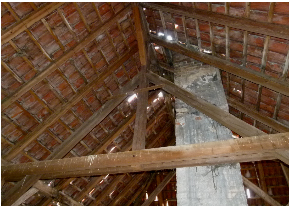
▲ Pohled do novodobého krovu vaznicové konstrukce nad severním křídlem.
