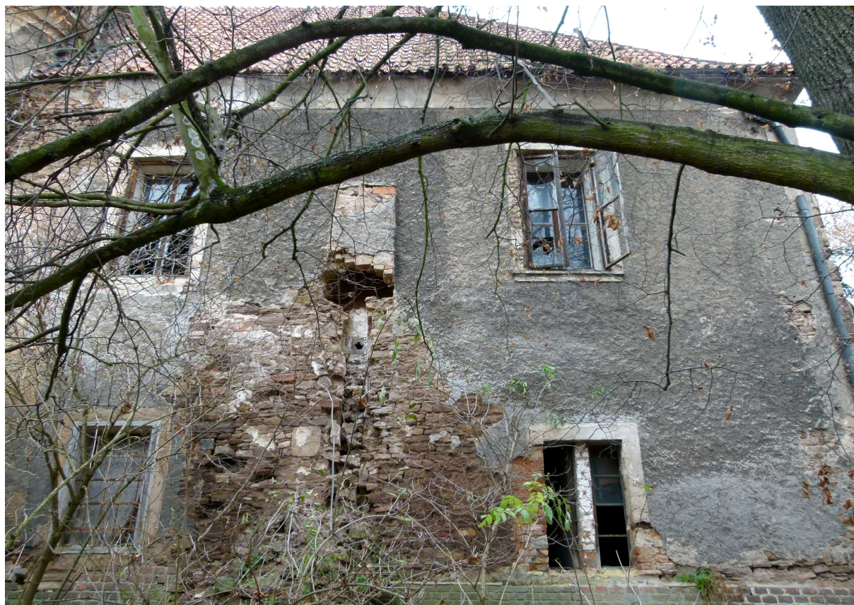
▲ Pohled na východní fasádu s arkýřovým záchodem a torzem záchodové šachty.
