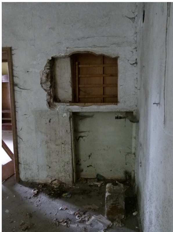
▲ Přezděná nika pro umístění kachlových kamen v místnosti 113.
