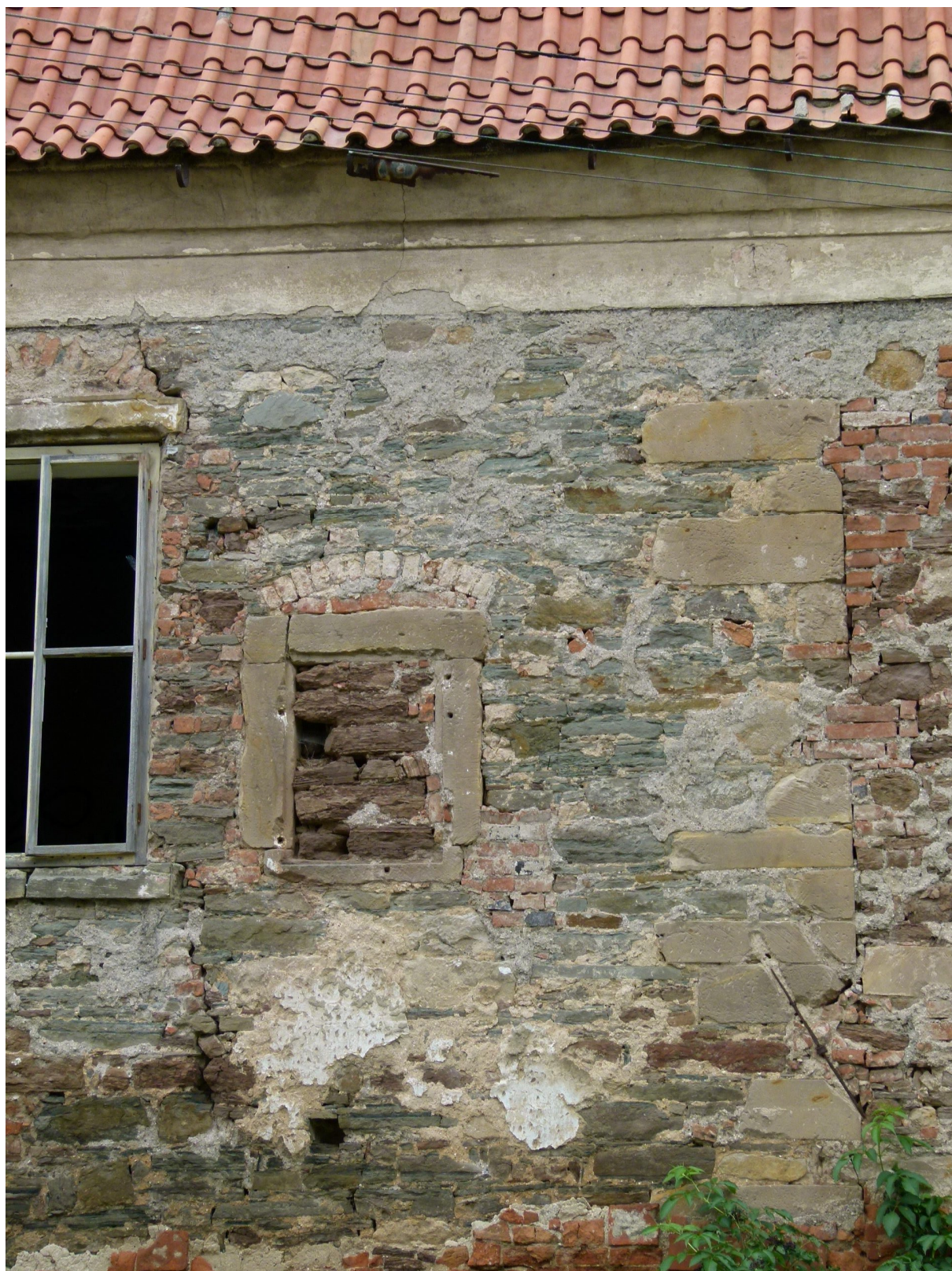
▲ Detail západní fasády severního křídla se zazděnými raně renesančními okny a vysokými vrcholně barokními okny s kamenným parapetem a nadpražím, vpravo nárožní armatura staršího jádra a dále pozdně renesanční přístavba jižního traktu provedená z odlišného lomového kamene, nahoře jednotící profilovaná římsa pravděpodobně vrcholně barokního stáří, dole pozůstatky pekované bílené omítky.
