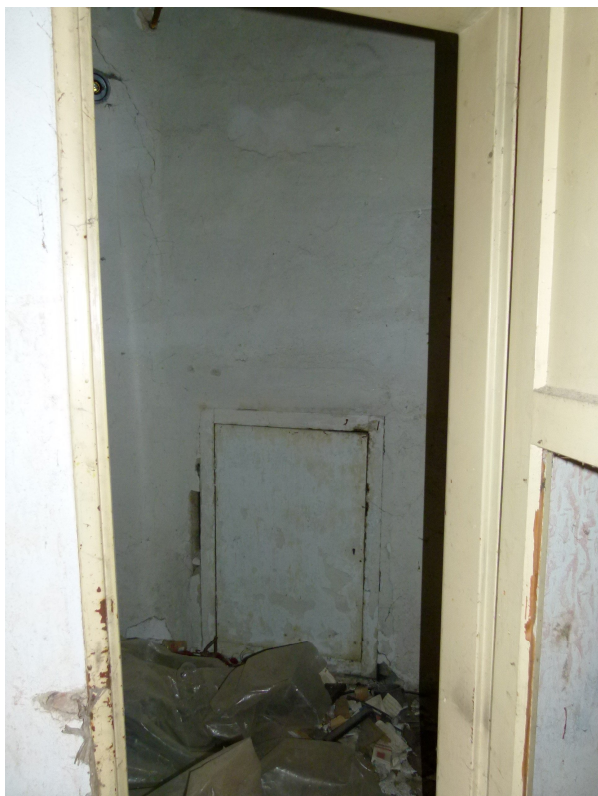
▲ Dvířka pro obsluhu kamen v místnosti 103 lemovaná kamenným ostěním.
