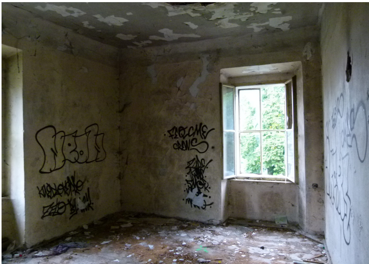
▲ Místnost 108 v patře severozápadního nároží severního křídla.
