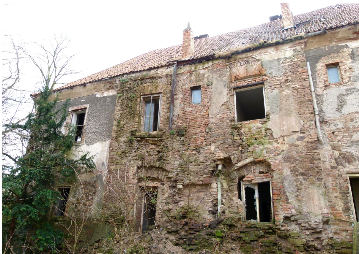
▲ Pohled na severní fasádu akcentovanou osovým rizalitem.
