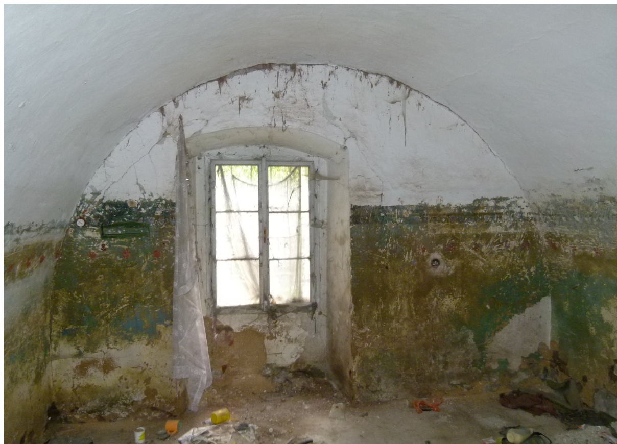
▲ Místnost P08 zaklenutá barokní klenbou. Na stěnách výmalba z 2. poloviny 19. století.
