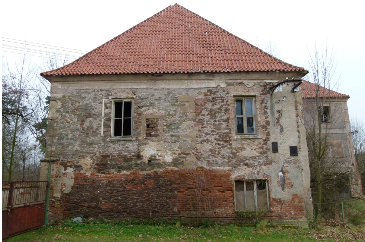
▲ Pohled na západní fasádu budovy.
