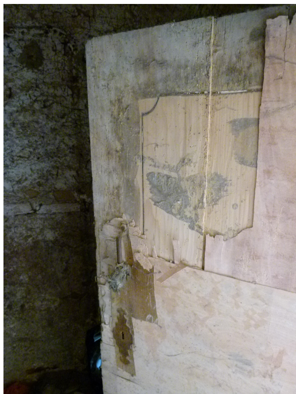
▲ Barokní dveře s plochým klíčovým štítkem v místnosti P02.
