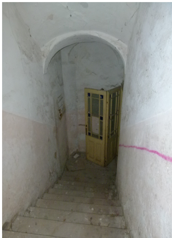
▲ Mezpodesta barokního schodiště s vymetacím otvorem komína.
