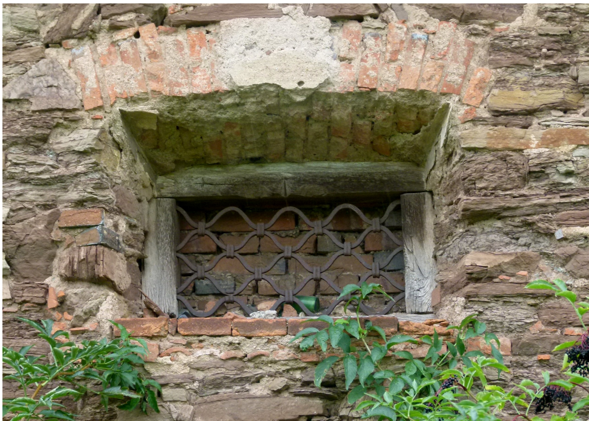
▲ Detail sýpkového okna s dřevěným trámkovým ostěním a vlnkovitou mříží.
