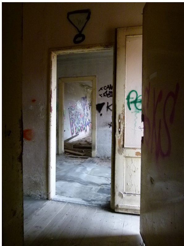
▲ Průhled druhým patrem východního křídla přistavěného ve 20. letech 20. století.
